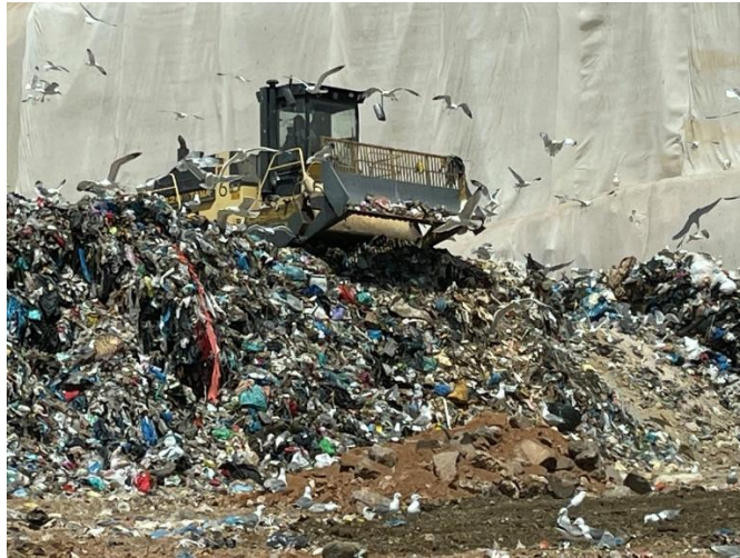
Εικόνα 23. Συμπύεση επι του μετωπικού πρανούς
