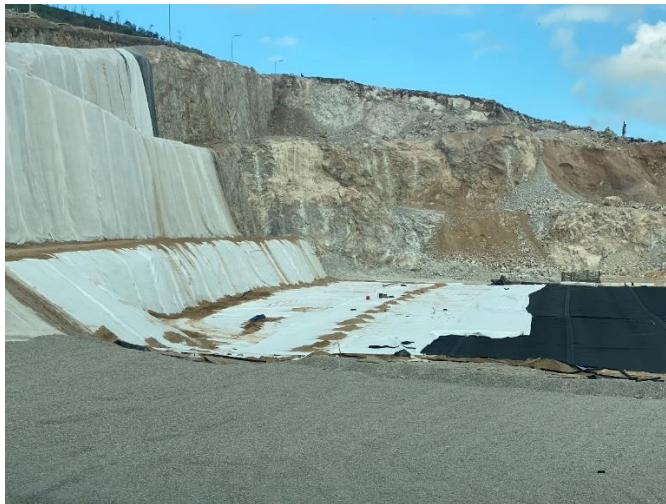
Εικόνα 9. Στεγανοποίηση κυττάρου και αποστραγγιστική στρώση
