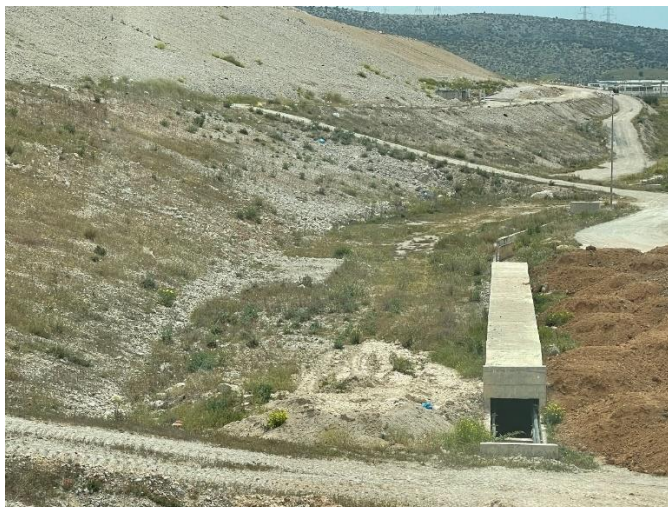
Εικόνα 10. Περιμετρικό ανάχωμα/ευστάθειας και τάφος μεταφοράς ομβρίων
