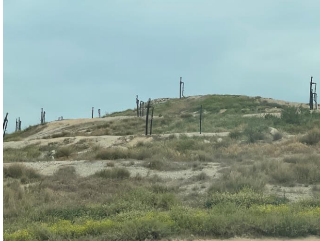
Εικόνα 14. Κατακόρυφα φρεάτια - αγωγοί συλλογής βιοαερίου (πηγάδια)
