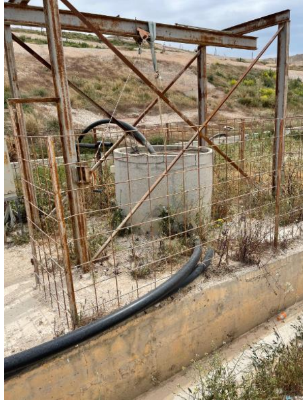
Εικόνα 11. Φρεάτιο συλλογής στραγγισμάτων 1
