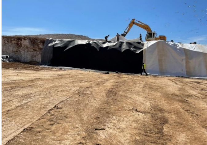
Εικόνα 5. Στεγανοποίηση πρανούς υπεδάφιου πυθμένα
