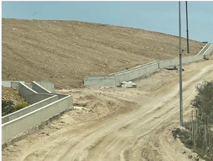
Εικόνα 24. Β' φάση επικάλυψης – διευθέτηση πρανών – τάφος απορροής ομβρίων ανάντι τμήματος
