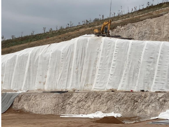
Εικόνα 8. Γεωσυνθετική αποστραγγιστική στρώση για κατακόρυφα πρανή
