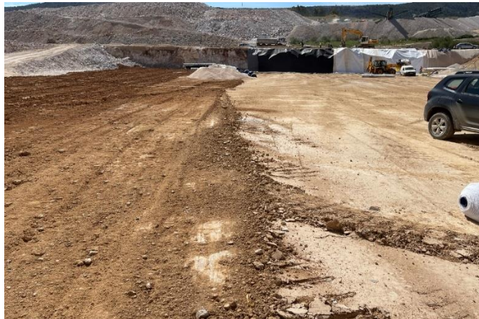
Εικόνα 6. Αργλικός φραγμός προ και μετά συμπίκνωσης
