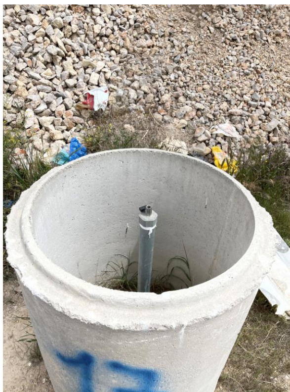
Εικόνα 20. Φρεάτια ελέγχου βιοαέριου
