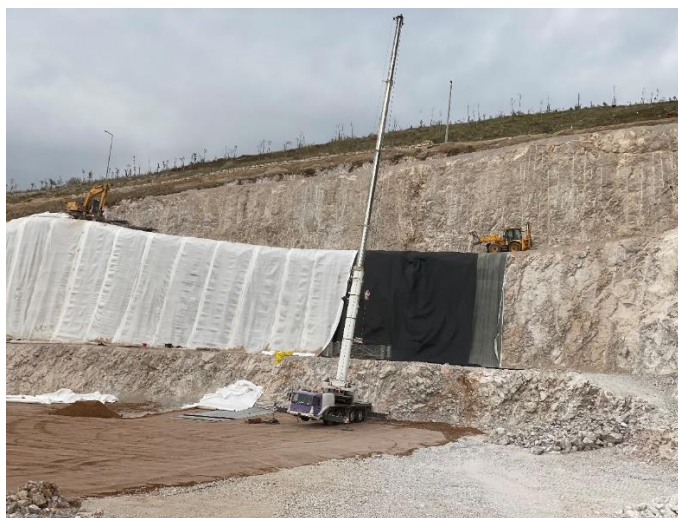
Εικόνα 4. Διαμόρφωση πυθμένα-Στεγανοποίηση πρανών
