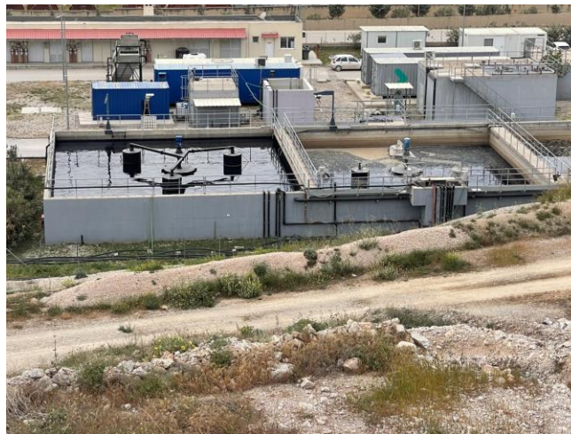
Εικόνα 17. Έργα διαχείρισης στραγγισμάτων - βιολογικός καθαρισμός
