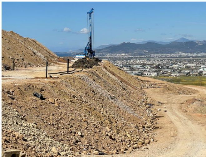
Εικόνα 13. Δημιουργία κατακόρυφων φρεατίων βιοαερίου
