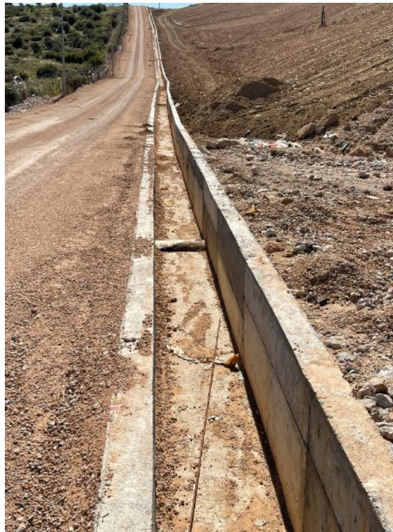
Εικόνα 16. Τάφρος ομβρίων - Περιμετρική ζώνη - Β' αποκατάσταση κυττάρου
