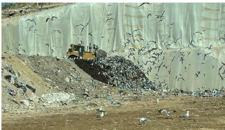
Εικόνα 22. Προώθηση και διάστρωση στη στέψη του μετωπικού πρανούς
