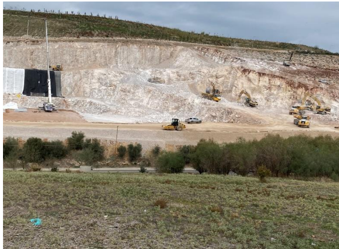
Εικόνα 2. Εκσκαφή ορύγματος με χρήση μηχανήματων και εκρηκτικών
