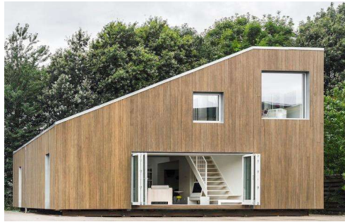
Εικ. 32 «Οι προσόψεις του κτηρίου έχουν επενδυθεί με επιφάνειες μπαμπού.» Πηγή: https://passivehouseplus.ie/blogs/an-active-house-built-from-shipping-containers
