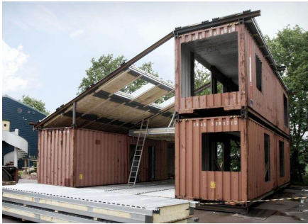
Εικ. 31 «Ο σκελετός της κατοικίας.» Πηγή: https://passivehouseplus.ie/blogs/an-active-house-built-from-shipping-containers
