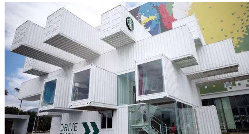
Εικ. 1 «Κατάστημα Starbucks, Taiwan.» Πηγή: https://www.diegocoquillat.com/en/la-nueva-apuesta-sostenible-de-starbucks-es-la-arquitectura-con-contenedores-intermodales/
