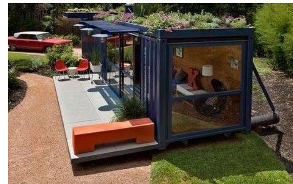
Εικ. 39 «Η λεγόμενη πράσινη στέγη βοηθά στην διατήρηση χαμηλών θερμοκρασιών στο χώρο.» Πηγή: http://sharevid.ru/index.php?s=blogsforwoman.wuvely.ru&p=537760-house-green-roof-shipping-containers-56-ideas.html
