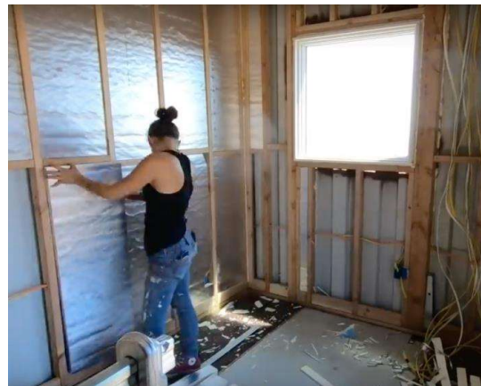
Εικ. 18 «Εφαρμογή μόνωσης.» Πηγή: https://www.youtube.com/watch?v=XIHxMrXt_0U
