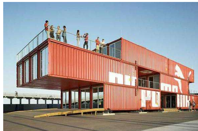
Εικ. 6 «Puma city: Στόχος των δημιουργών του ήταν η γρήγορη και εύκολη μεταφορά και συναρμολόγηση στα μέρη που θα λαμβάνει μέρος. Πηγή : https://www.archdaily.com/10620/puma-city-shipping-container-store-lot
