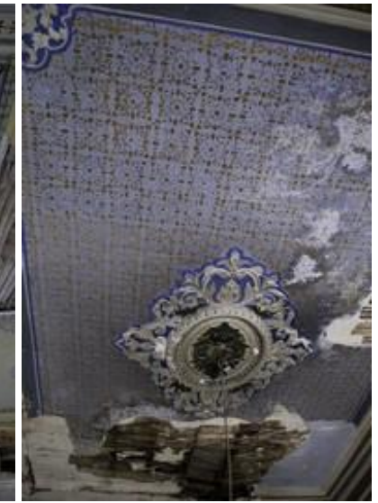
Εικ. 58 Όροφος Πηγή:chioshouses.gr
