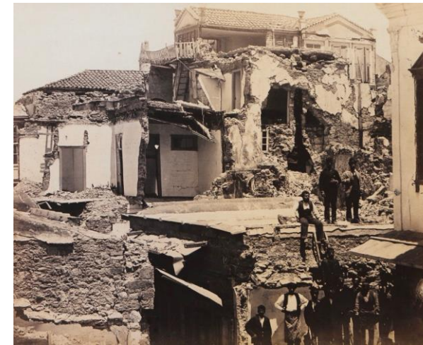
Εικ. 10 Η οδός Απλωταριάς στη Χίο ύστερα από τον φονικό σεισμό στα 1881
