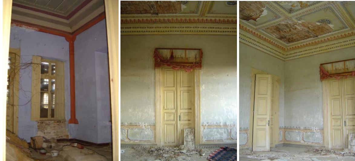
Εικ. 65 Όροφος (φωτ. Β. Αγιαννίδη) Πηγή:aplotaria.gr
