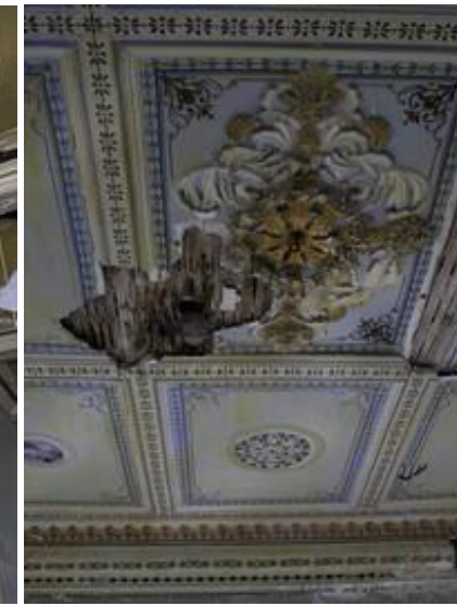
Εικ. 57 Όροφος Πηγή:chioshouses.gr
