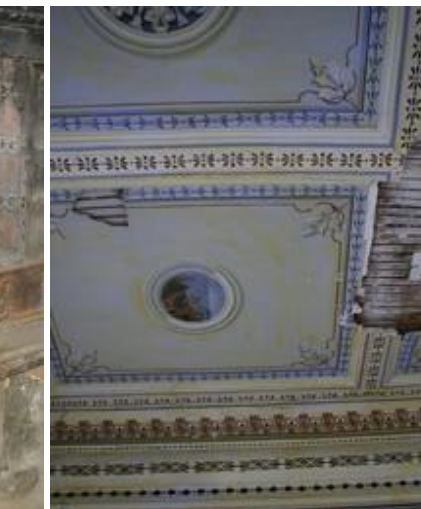
Εικ. 63 Όροφος Πηγή:chioshouses.gr
