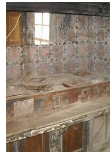
Εικ. 62 Όροφος Πηγή:chioshouses.gr
