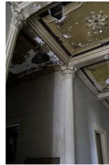
Εικ. 56 Όροφος Πηγή:chioshouses.gr
