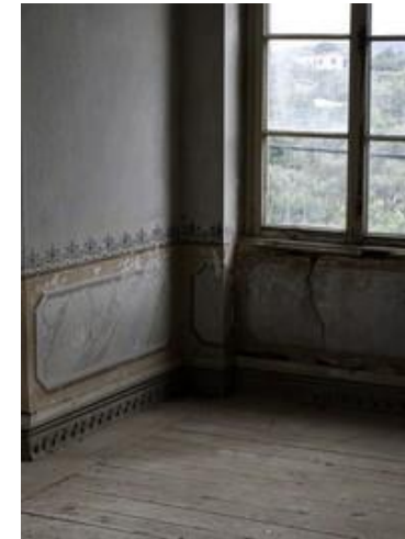
Εικ. 59 Όροφος Πηγή:chioshouses.gr
