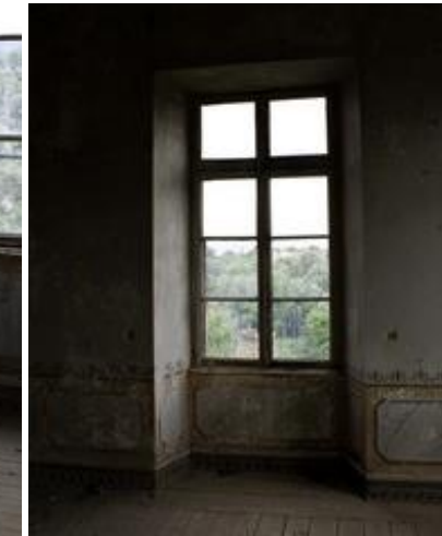
Εικ. 60 Όροφος Πηγή:chioshouses.gr
