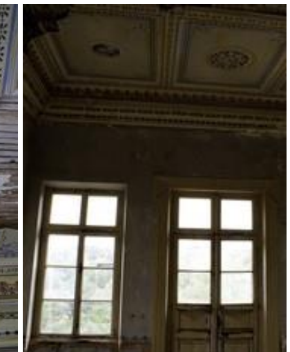
Εικ. 64 Όροφος Πηγή:chioshouses.
