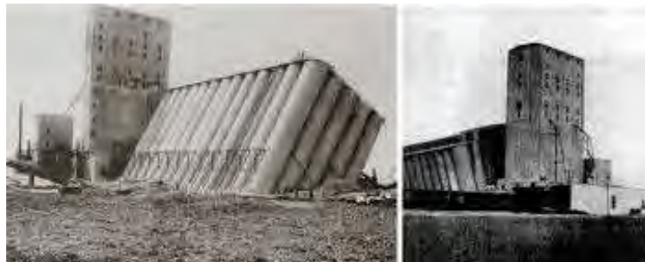
Εικόνα 3.6: Αστοχία θεμελίωσης, γενική θραύση North Transcona, Manitoba, Canada (1913)
