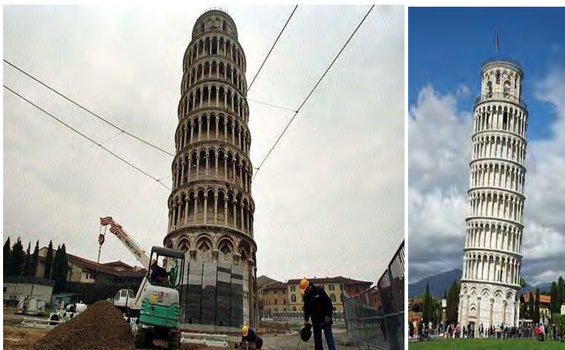
Εικόνα 1.1: Αστοχία εδάφους θεμελίωσης κεκλιμένος πύργος Πίζας (Εκπαιδευτικές σημειώσεις για το μάθημα των θεμελιώσεων Γ.Μπελόκας)
