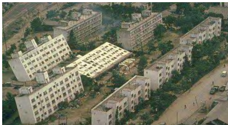
Εικόνα 3.7: Αστοχία θεμελίωσης, ολική θραύση Niigata (1964)
