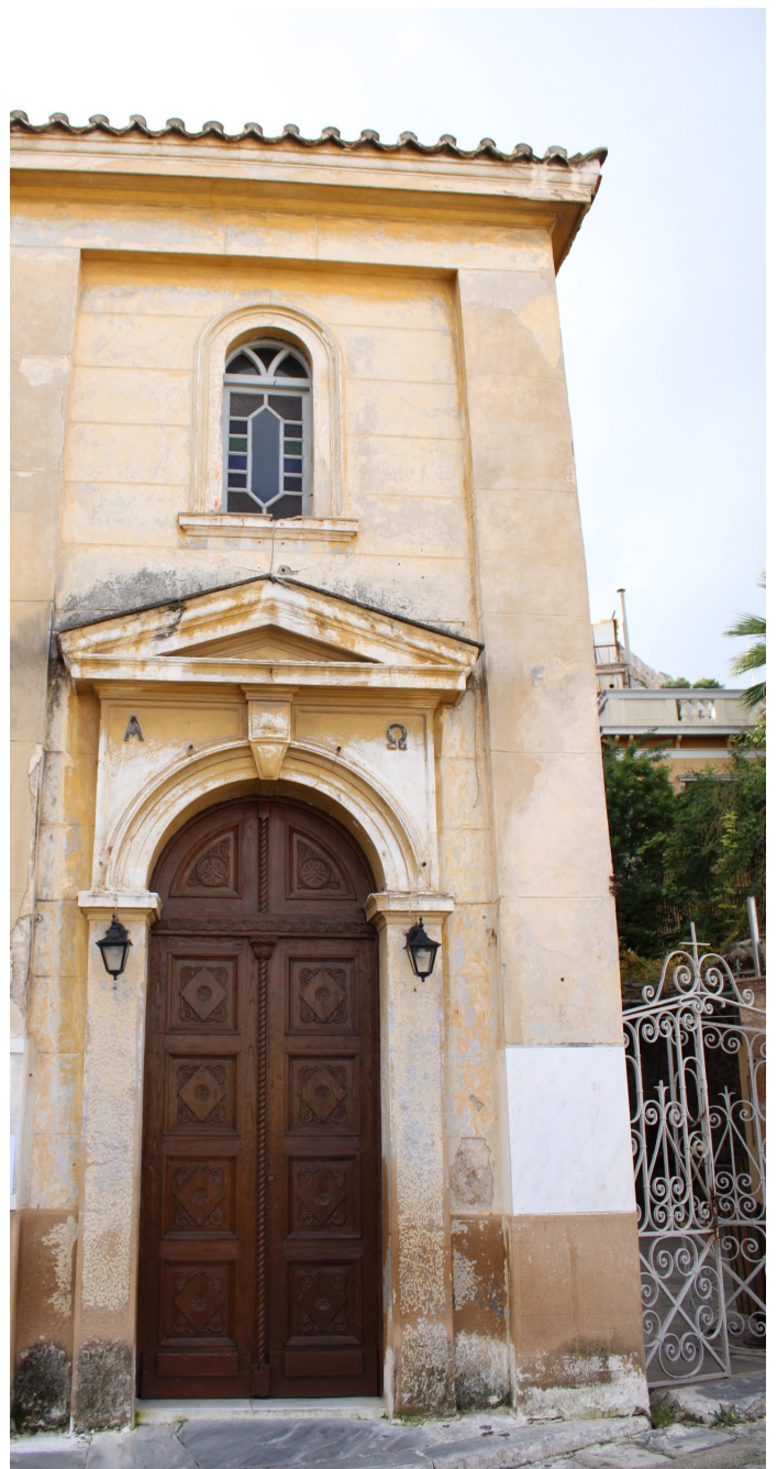
Εικόνα 2.4.27: Απεικόνιση του επιχρίσματος στην Βορειοδυτική πλευρά του μνημείου
