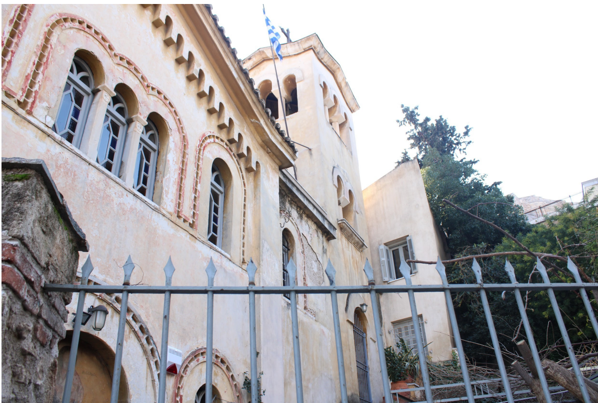
Εικόνα 2.3.7: Η Δυτική όψη του Αγίου Νικολάου Ραγκαβά
