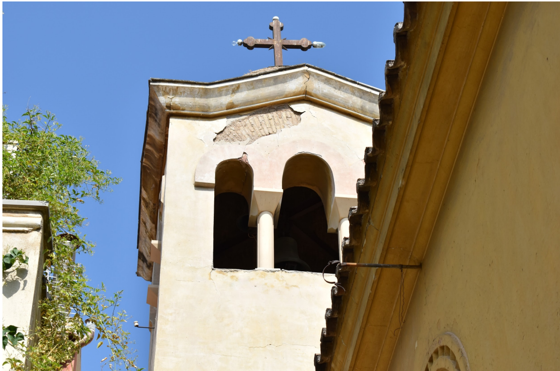
Εικόνα 3.1.2.33: Φωτογραφική αποτύπωση της Ανατολικής πλευράς του κωδωνοστασίου με έμφαση την απώλεια δομικού υλικού στην περιοχή πάνω από την αριστερή καμάρα
