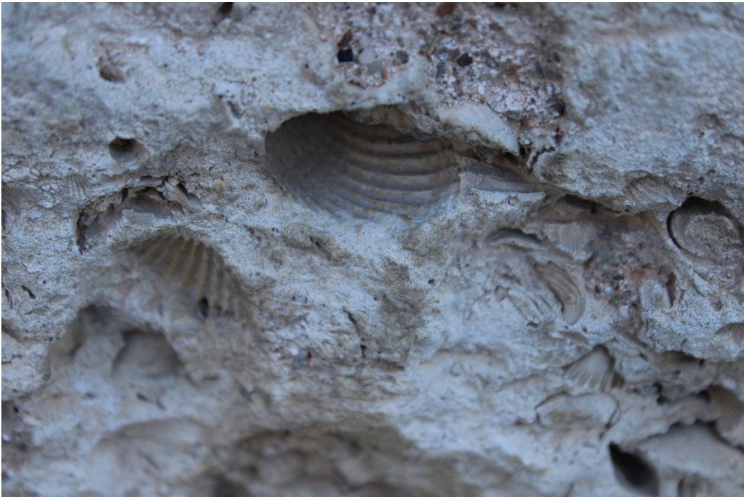
Εικόνα 2.1.1.2: Κογχυλιάτης λίθος από την Βόρεια όψη του ναού
