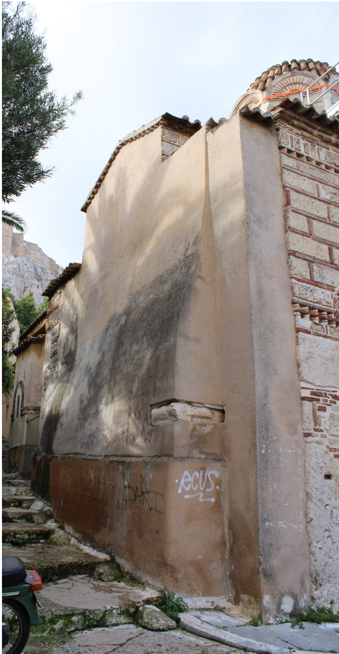
Εικόνα 2.4.26: Απεικόνιση επιχρίσματος στην Ανατολική πλευρά του μνημείου
