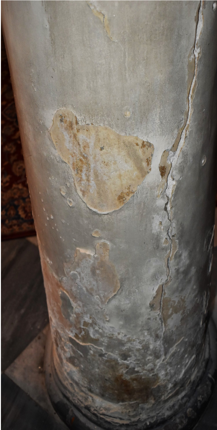
Εικόνα 3.1.2.28: Απολέπιση των υλικών δόμησης στο βάθρο της Νοτιοανατολικής κολώνας στο εσωτερικό του ναού.
