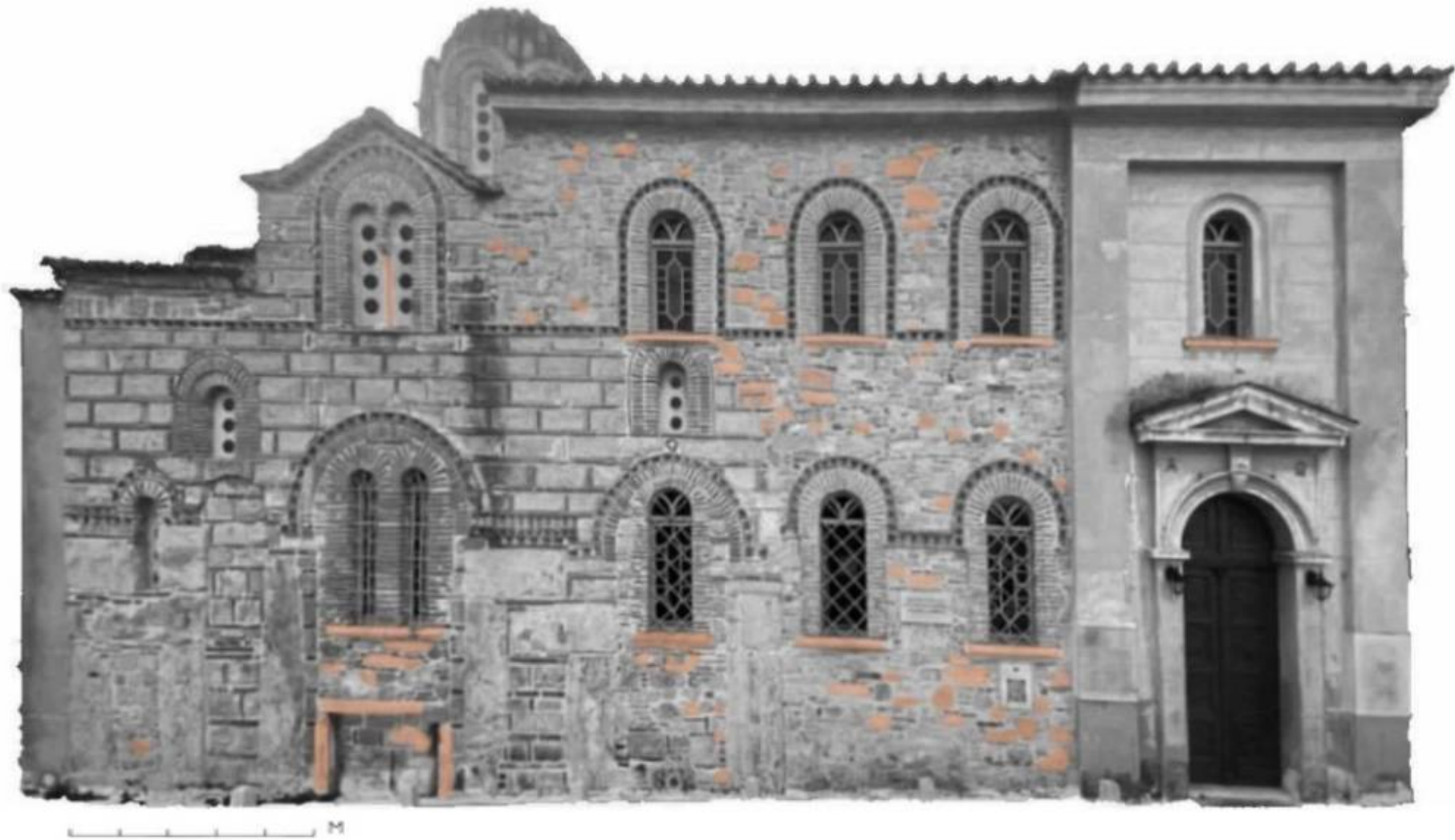
Σχήμα 2.1.1.8: Χαρτογράφηση μαρμάρων στον βόρειο τοίχο του Ι.Ν. Αγίου Νικολάου Ραγκαβά
