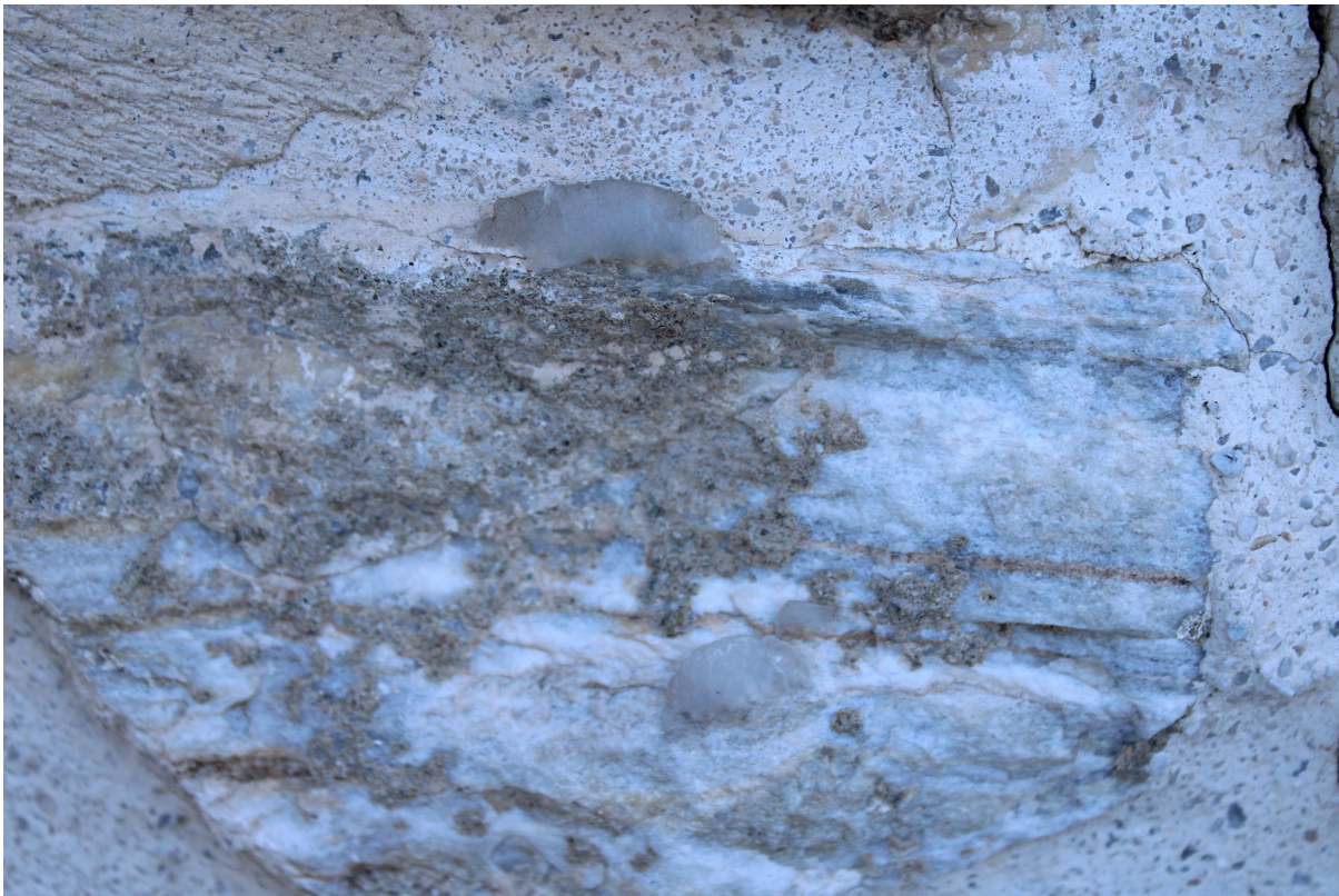
Εικόνα 2.1.1.1: Μάρμαρο στην τοιχοποιία της Βόρειας όψης του Ι.Ν Αγίου Νικολάου Ραγκαβά
