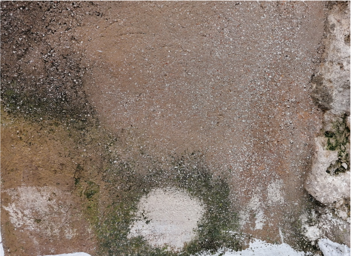
Εικόνα 3.3.37: Ανάπτυξη βιολογικών μικροοργανισμών στο κάτω μέρος της βορειοανατολικής πλευράς του Ι.Ν. του Αγίου Νικολάου Ραγκαβά
