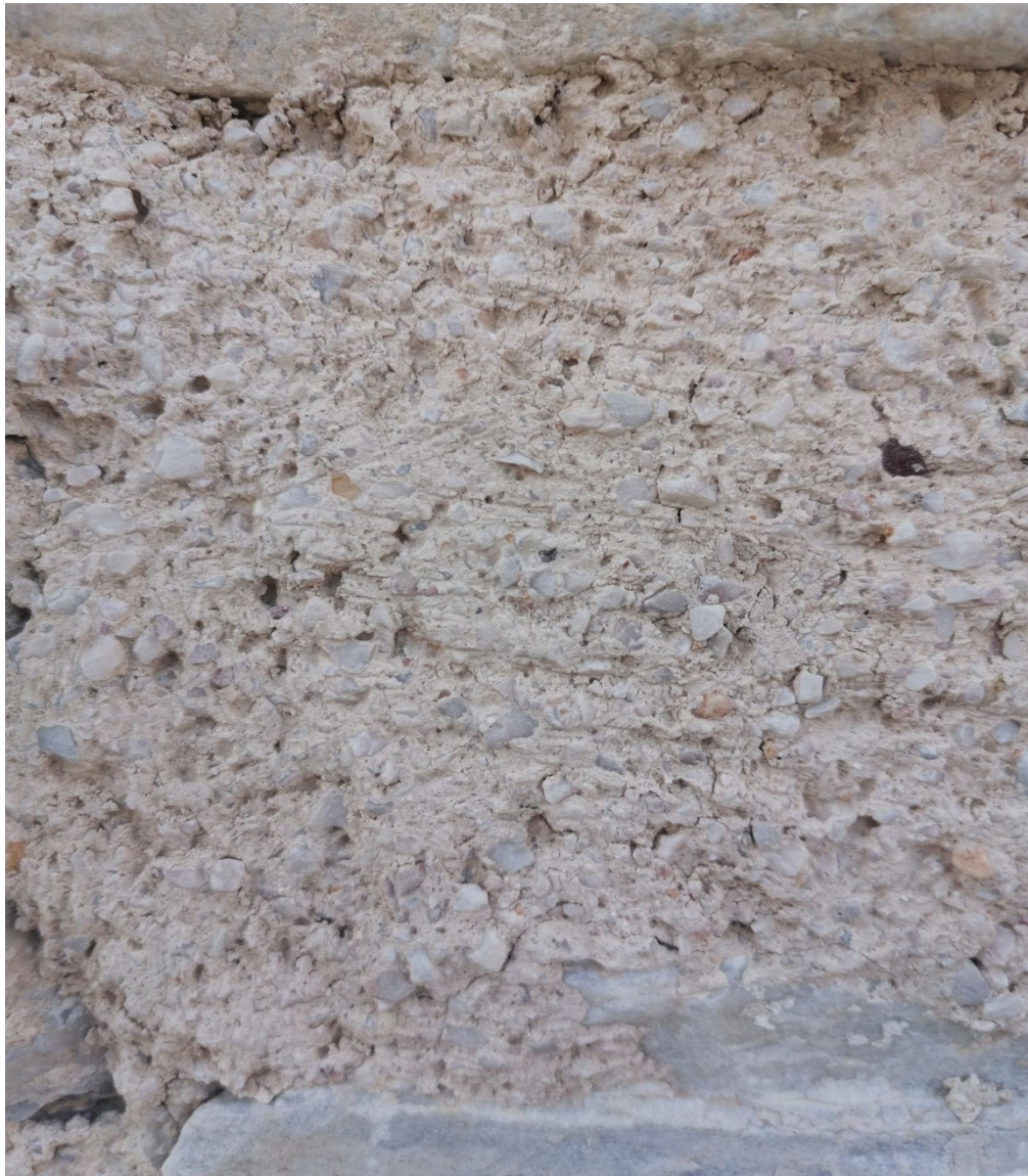
Εικόνα 2.2.5: Κονίαμα δεύτερης οικοδομικής φάσης
