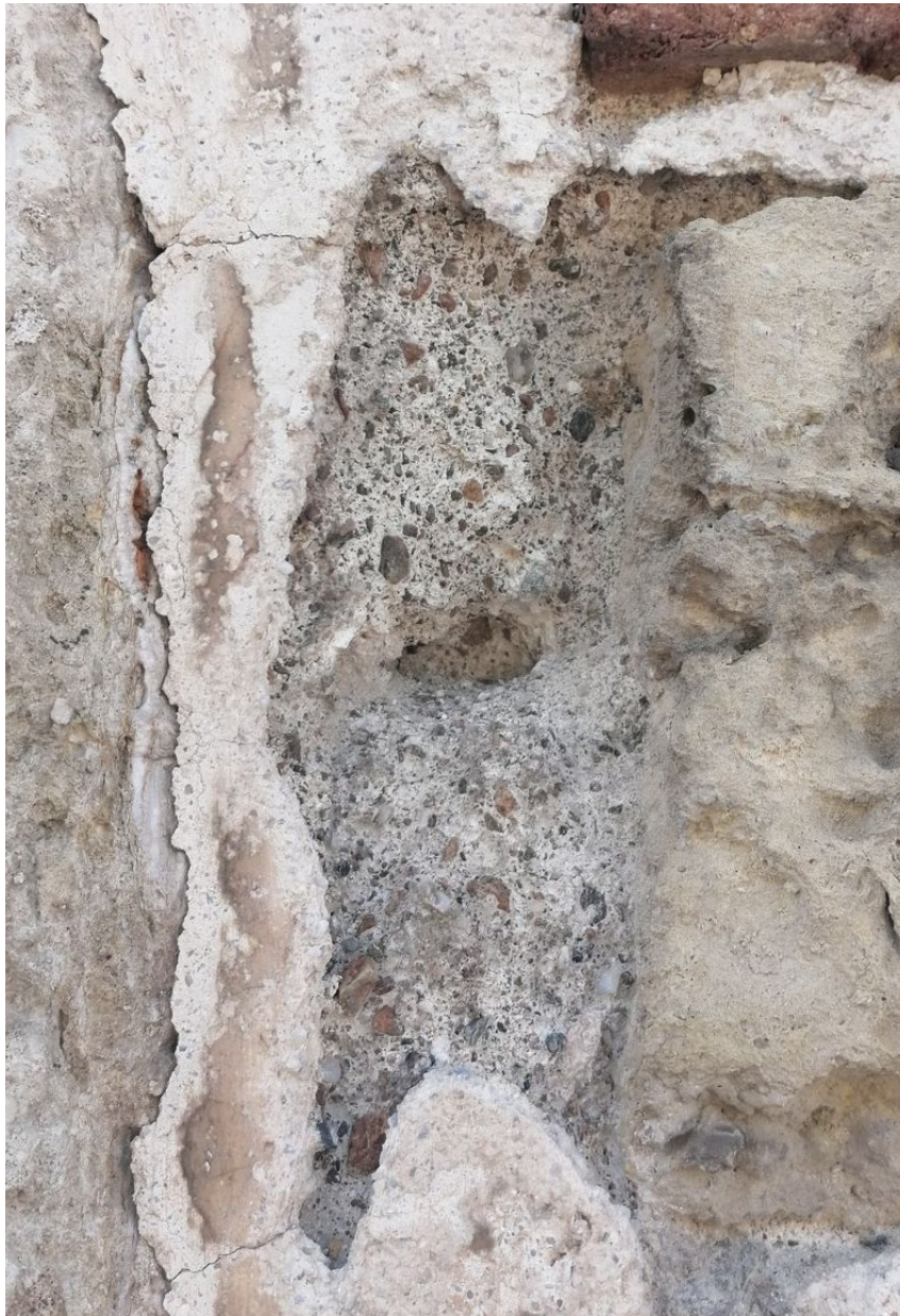
Εικόνα 2.2.3: Δομικό κονίαμα πρώτης οικοδομικής φάσης
