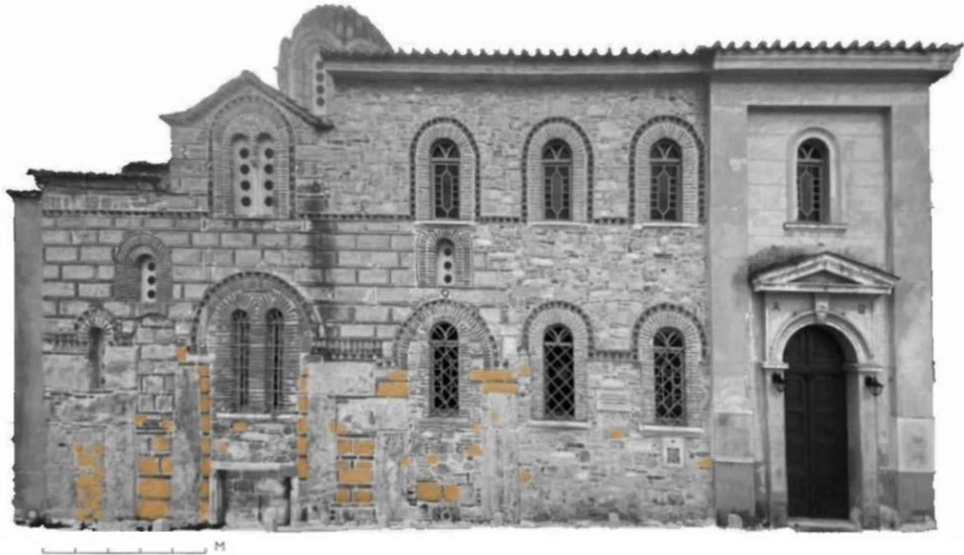
Σχήμα 2.1.1.9: Χαρτογράφηση κογχυλιόλιθων στον βόρειο τοίχο του Ι.Ν. Αγίου Νικολάου Ραγκαβά
