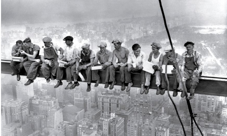
Εικόνα 2.2 Εργάτες μεταλλικών κατασκευών, Σικάγο 1932
