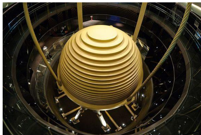
Εικόνα 3.9 Συντονισμένη μάζα απόσβεσης εντός του Ταϊπέι 101
