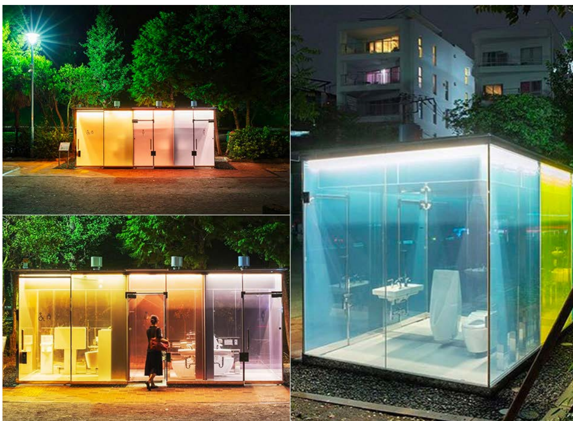
Εικ. 87: Έργο: The Tokyo Toilet Project. Shibuya 2021.
