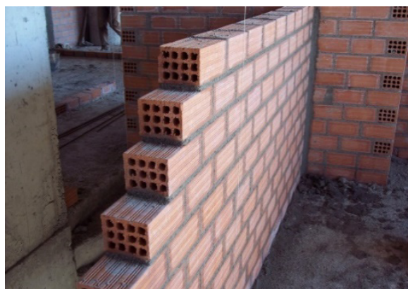
Εικόνα 1.5 Δρομική Τοιχοποιία
