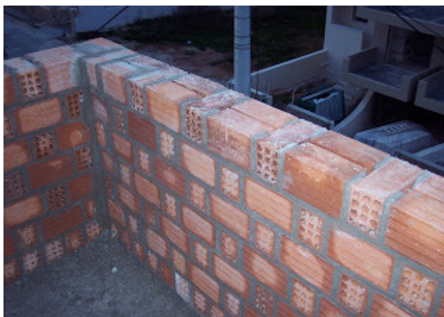
Εικόνα 1.6 Μπατική Τοιχοποιία
