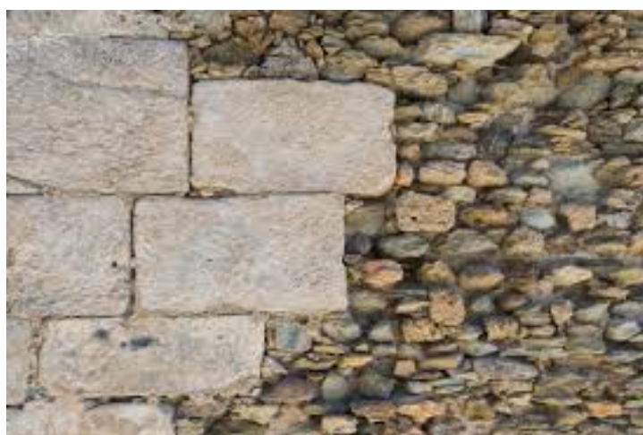
Εικόνα 1.10 Συνδετική Τοιχοποιία
