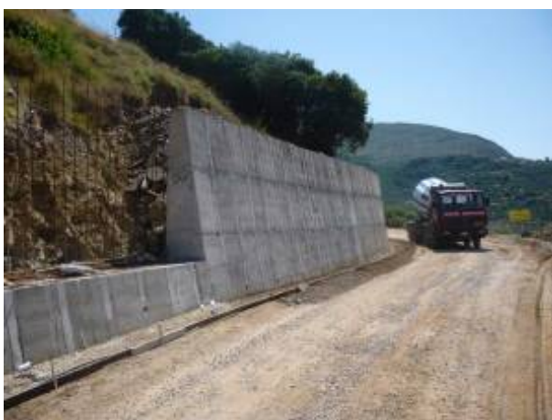
Εικόνα 1.12 Τοίχος Αντιστήριξης
