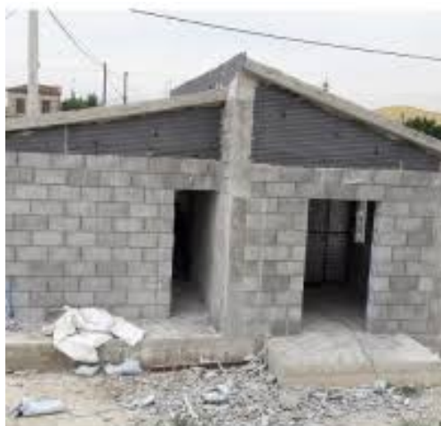
Εικόνα 1.3 Τσιμεντολιθοδομή
