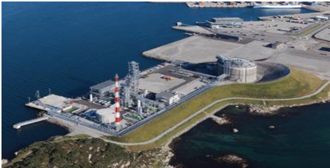
Εικόνα 2.5. Μικρός τερματικός σταθμός ΥΦΑ, πηγή (Linde Engineering, 2021).
