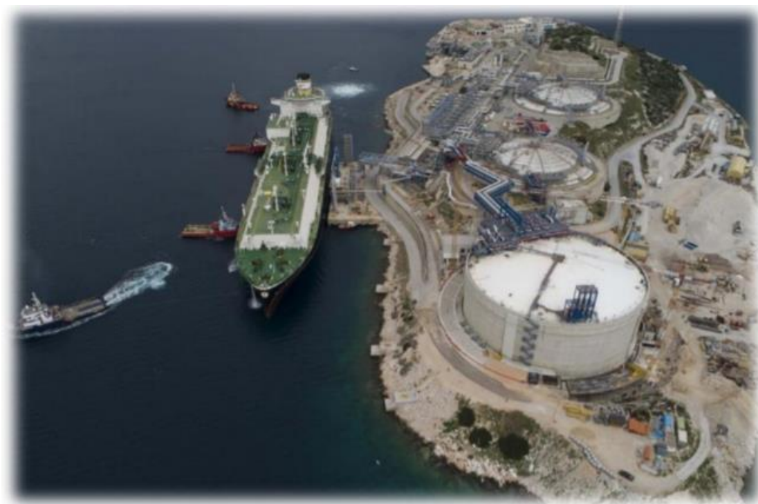
Εικόνα 3.3. Η εγκατάσταση ΥΦΑ της Ρεβυθούσας, πηγή (ΔΕΣΦΑ, 2021)
