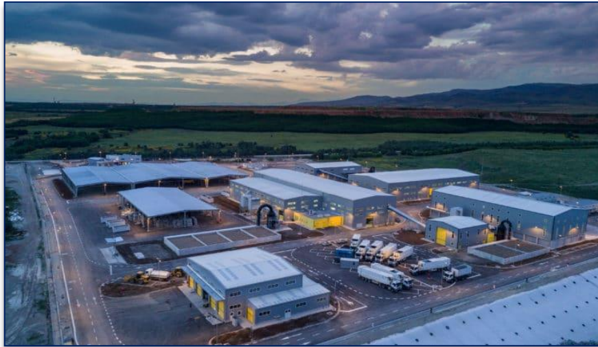
Εικόνα 10. Εγκαταστάσεις Διαχείρισης Αποβλήτων Δυτικής Μακεδονίας [106]
