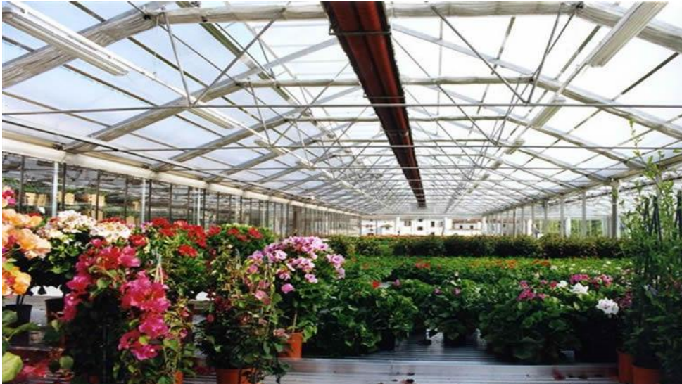
Εικόνα 17: Το πρώτο θερμοκήπιο στην Ελλάδα που θερμαίνεται με κάτοπτρα υπέρυθρης ακτινοβολίας (2011-2012).
