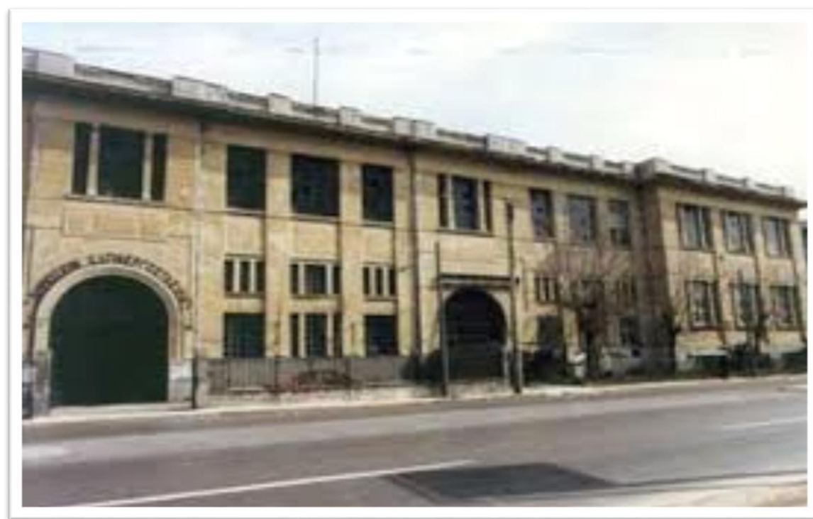
Εικόνα 6 Η πρόσοψη του Παλαιού Καπνεργοστασίου πριν τις επεμβάσεις. Πηγή: ΟΑΣΙΣ
