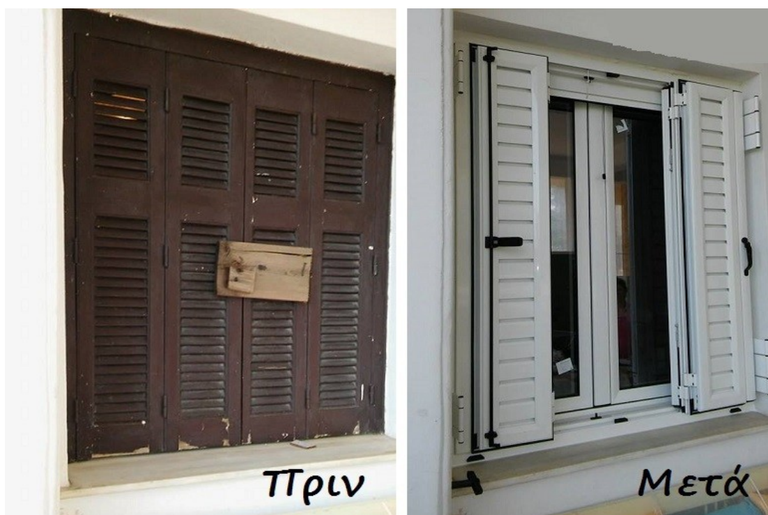
Εικόνα 5.12 : Παράδειγμα Αντικατάστασης Κουφωμάτων Παραθύρου
