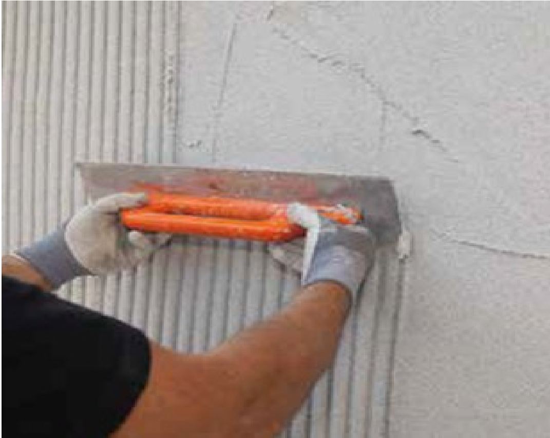
Εικόνα 5.8 : Εφαρμογή Κόλλας https://www.renovat.gr/technical/thermoprosopsi
