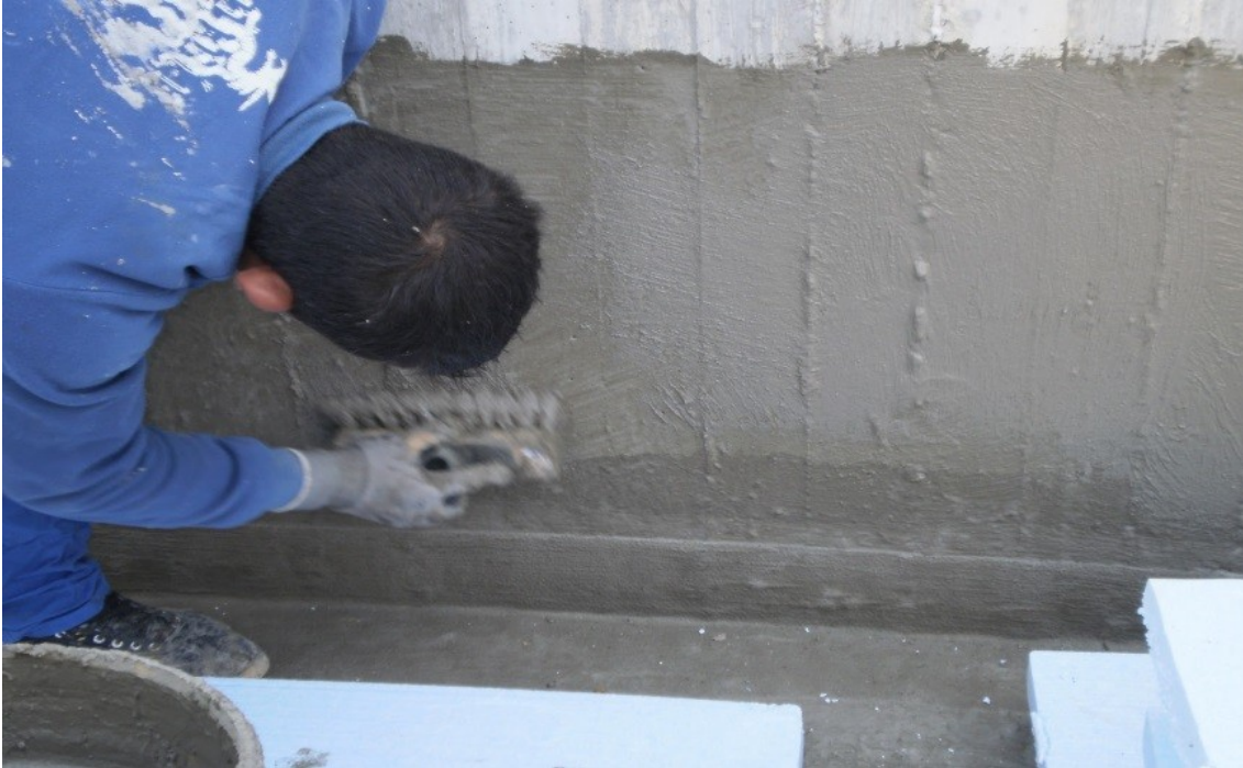
Εικόνα 5.4 : Εφαρμογή Τσιμεντοειδούς Στεγανωτικού
