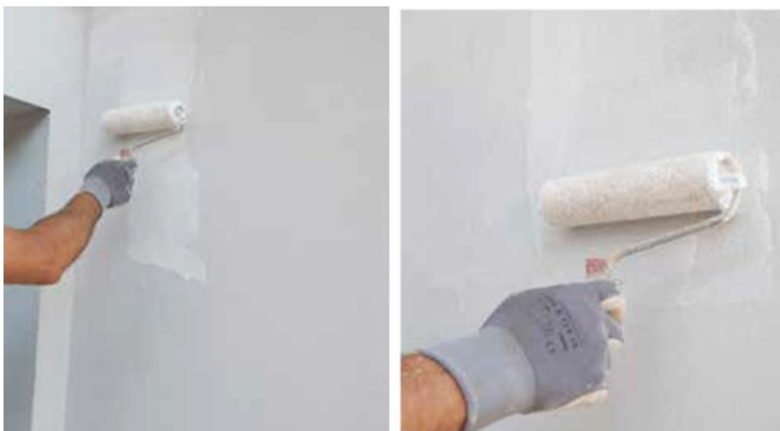
Εικόνα 5.10 : Εφαρμογή Τελικού Επίχρισματος
