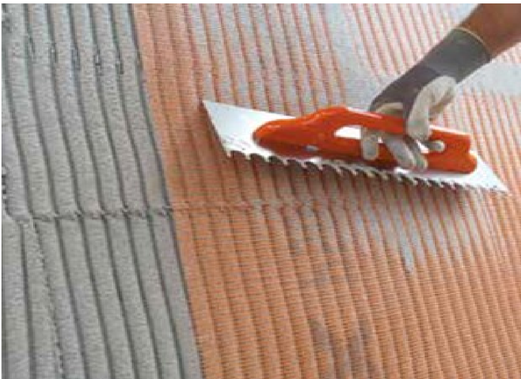
Εικόνα 5.9 : Τοποθέτηση Πλέγματος https://www.renovat.gr/technical/thermoprosopsi
