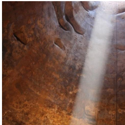
Εικόνα 7. Εσωτερικό δεξαμενής, ανώτερα τοιχώματα (φωτό: Α.Παπουτσάκη, 2018).
