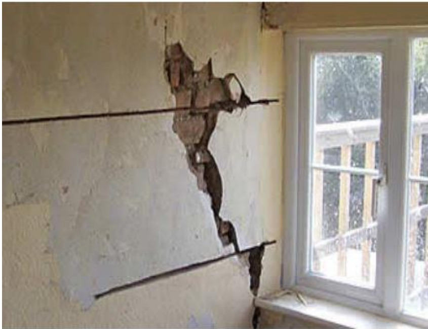
Σχήμα 2.5: Ενίσχυση με τη μέθοδο μεταλλικών στοιχείων
