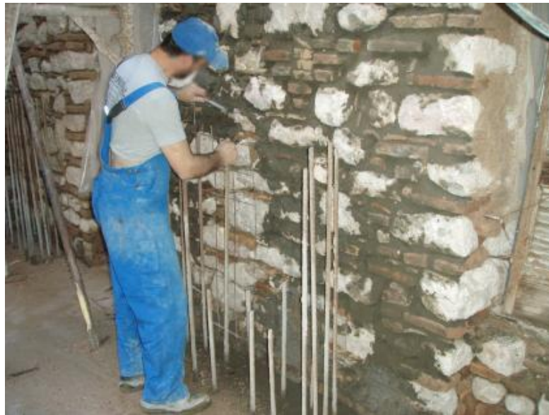
Σχήμα 2.3: Ενίσχυση με τη μέθοδο: βαθύ αρμολόγημα
