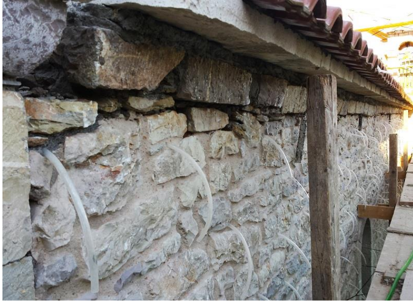
Σχήμα 2.4: Ενίσχυση με τη μέθοδο ενεμάτων
