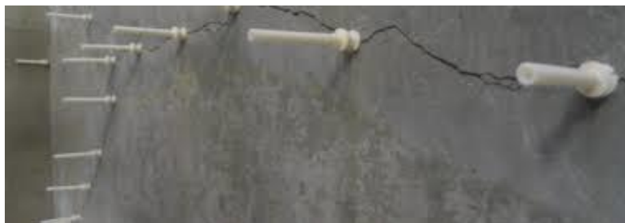
Σχήμα 3.5: Ενίσχυση με τη μέθοδο ρητινενέσεων
