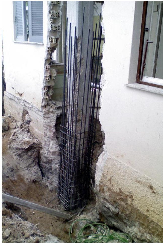
Σχήμα 3.7: Ενίσχυση με τη χρήση μανδύα (Πηγή: Build & Relax)
