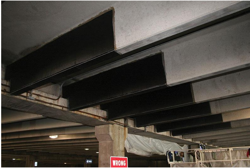
Σχήμα 3.6: Ενίσχυση με τη τεχνική FRP. (Πηγή: Tarek Alkhrdaji, 2015 , StructureMAG)
