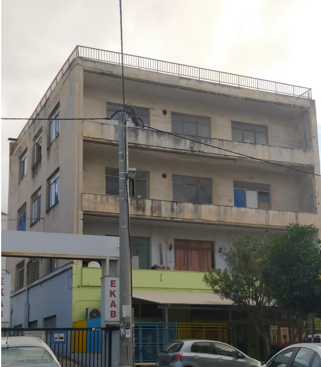
Εικ.2.1 Το προς εξέταση τετραώροφο δημοτικό κτίριο του Δήμου Γαλασίου
