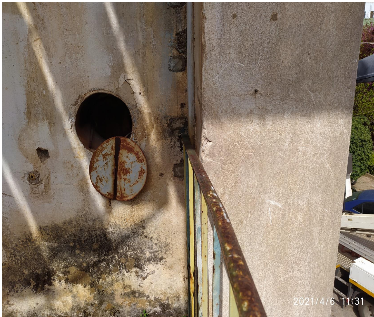
Εικ.2.4 Διαμπερής οπή στην τοιχοκολώνα Κ1(2)
