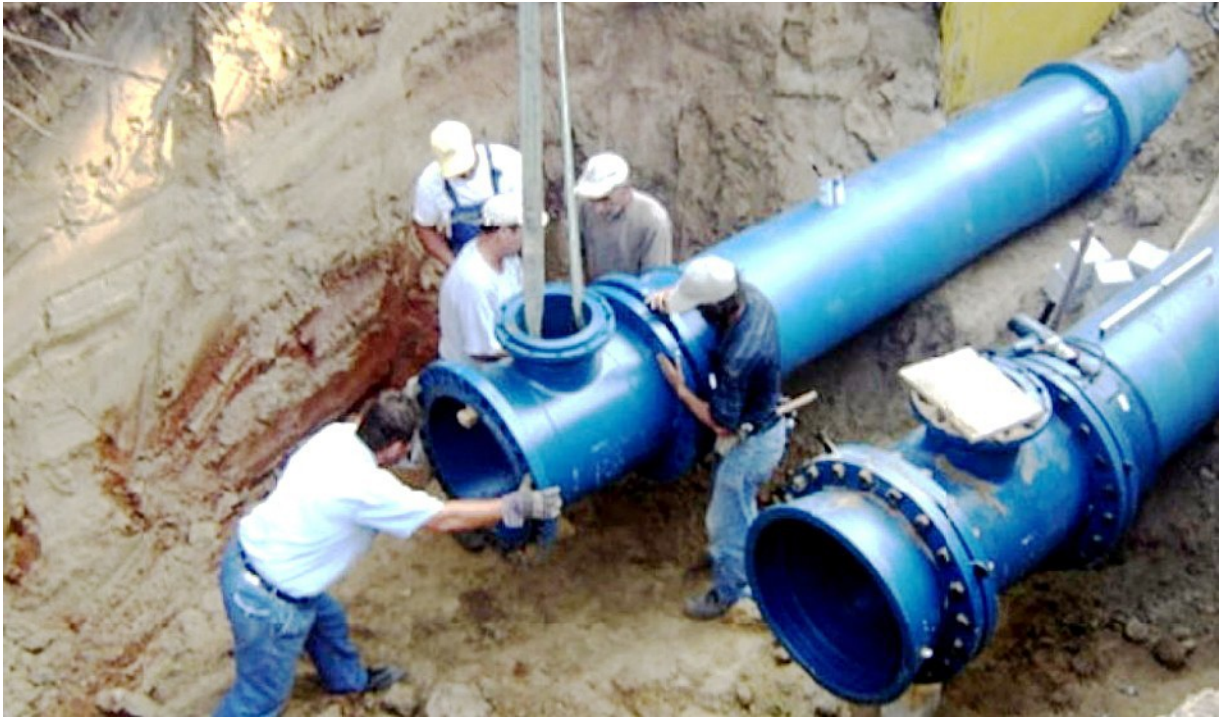
ΕΙΚΟΝΑ 1.6 ΤΟΠΟΘΕΤΗΣΗ ΑΓΩΓΩΝ ΓΙΑ ΜΕΤΑΦΟΡΑ ΠΟΣΙΜΟΥ ΝΕΡΟΥ
