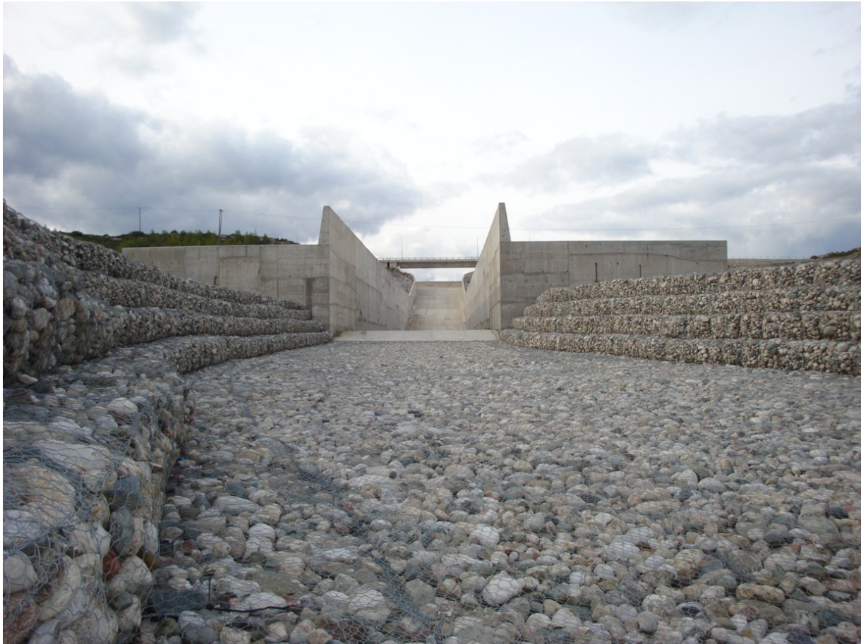
Εικόνα 5.4 Το φράγμα του Γαδουρά υπό κατασκευή με λιθορριπή
