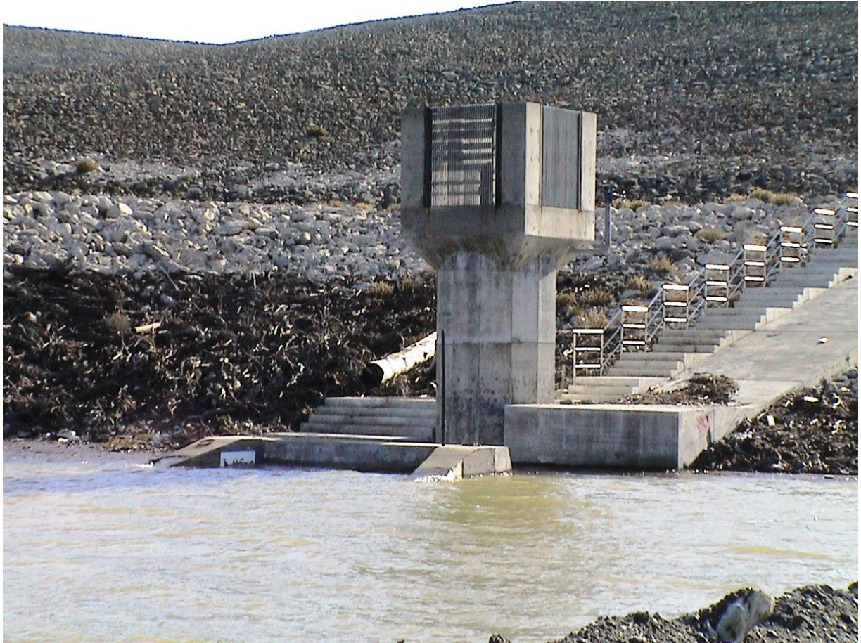
Εικόνα 5.3 το φράγμα του Γαδουρά υπό κατασκευή
