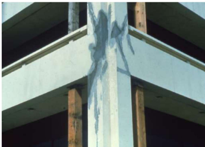
Εικόνα 5.2: Αποκατάσταση Της Διατομής ( https://pithos.okeanos.grnet.gr/public/h3iXTRDlmrLuVrEVWlpfD4 )
