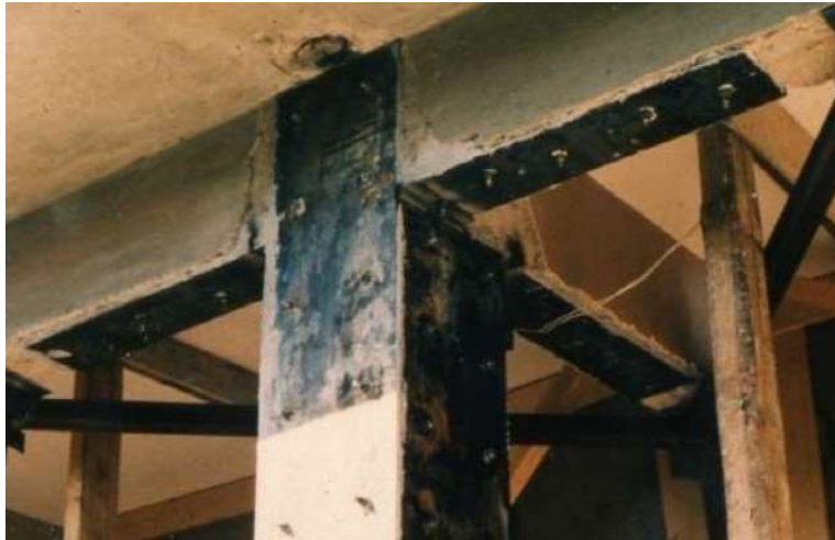
Εικόνα 5.4: Ενίσχυση κόμβου με επικολλητά χαλύβδινα ελάσματα ( https://pithos.okeanos.grnet.gr/public/h3iXTRDlmrLuVrEVWlpfD4 )
