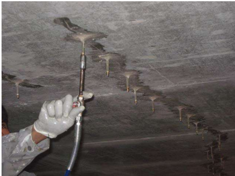
Εικόνα 5.1: Εφαρμογή ρητινένεσεων προς αποκατάσταση ρωγμής ( https://antienhung.vn/bien-phap-sua-chua-nut-be-tong/ )
