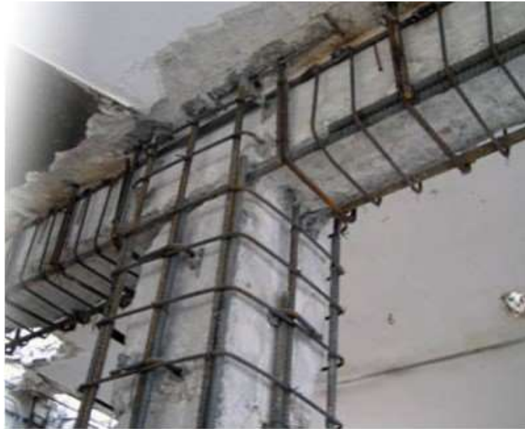
Εικόνα 5.3: Εφαρμογή Μανδύα Ο/Σ στον κόμβο ως συνέχεια του μανδύα του υποστυλώματος και των δοκών
