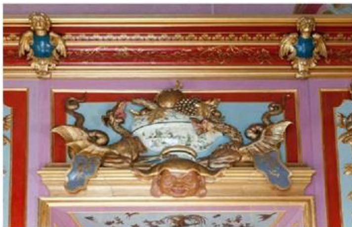
Εικ. 62: Άποψη του ανατολικού τοίχου μετά τις επεμβάσεις συντήρησης.
