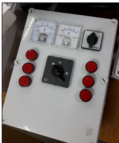
Εικόνα 3.3-23: Παράδειγμα κτιίου εξοπλισμού με εγκατεστημένα τα επιμέρους στοιχεία Αρχεϊακό υλικό
