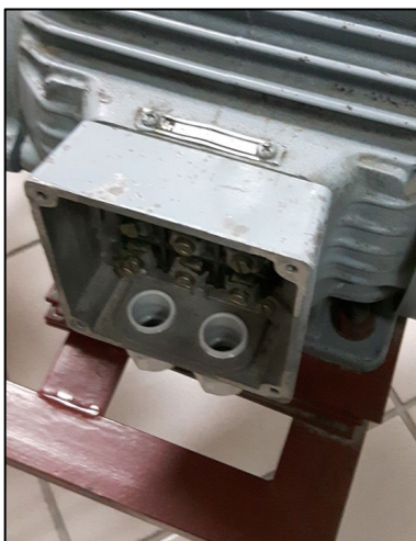
Εικόνα 3.3-4: Τοποθέτηση στυπιοθλιπτών στο κντίο συνδέσεων του κινητήρα Αρχειακό υλικό
