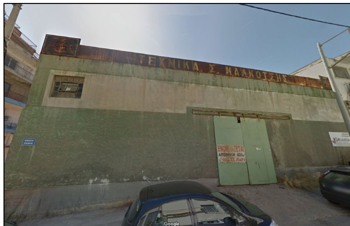
Εικόνα 3.3-2: Ο χώρος που στέγαζε το μηχανουργείο της εταιρείας "Τεχνικά Σ. Μαλκότσης"
