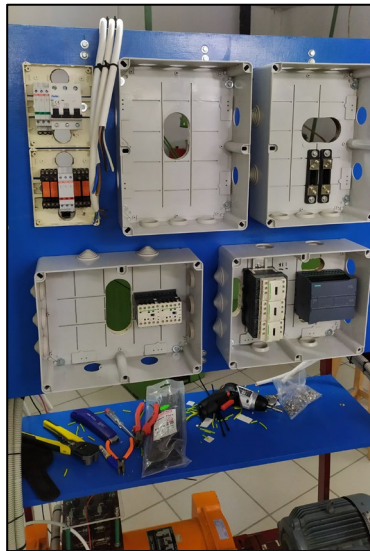
Εικόνα 3.3-36: Τοποθέτηση ηλεκτρολογικού και ηλεκτρονικού υλικού Αρχειακό υλικό
