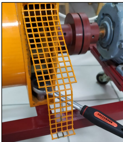
Εικόνα 3.5-2: Στιγμιότυπο της διαδικασίας σύσφιξης των κοχλιών συγκράτησης της γεννήτριας
