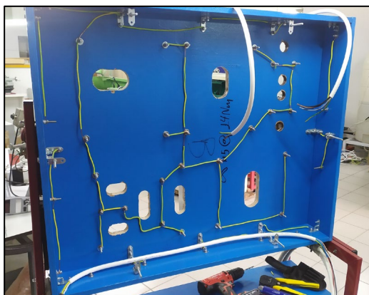
Εικόνα 3.3-35: Γείωση των εκτεθειμένων μεταλλικών στοιχείων στο κούτιο καλωδίωσης
