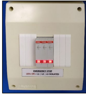
Εικόνα 4.2-14: Οπτική σήμανση λειτουργίας του κυκλώματος διακοπής Αρχειακό υλικό
