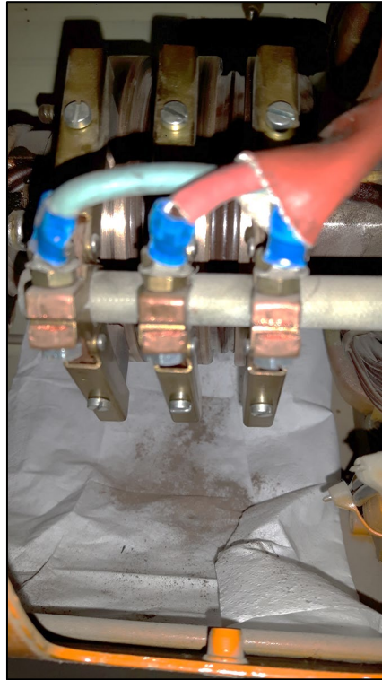
Εικόνα 3.3-11: Επιθεώρηση και καθαρισμός των δακτυλίων ολίσθησης και των ψηκτρών Αρχαιακό υλικό
