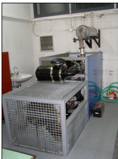
Εικόνα 3.2-3: Γενική άποψη της διάταξης Αρχειακό υλικό
