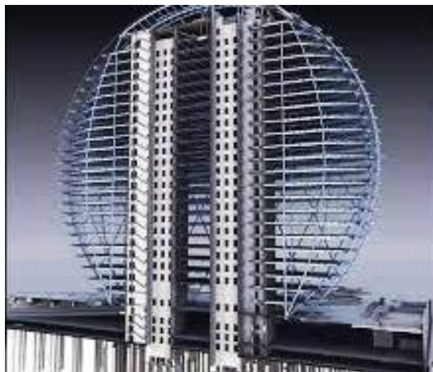
Εικόνα 6.20: Aldar Headquarters. πυρήνας σκυροδέματος κατά ζεύγη
