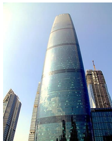
Εικόνα 6.3: International Finance Center, Κίνα, ορατά διαγώνια πλέγματα από το εσωτερικό του υαλοπετάσματος
