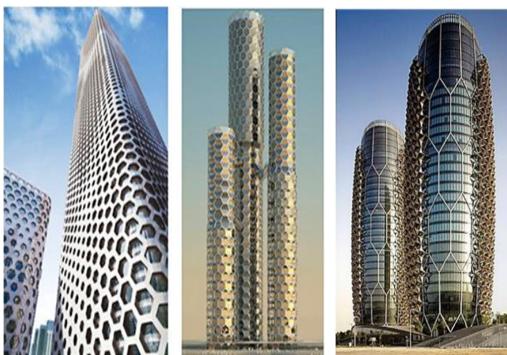
Εικόνα 7.8: Παραδείγματα κατασκευών με εξαγωνικό πλέγμα: a) Sino-Steel Tower, Κίνα b) Nano Towers, Αμπό Ντάμπι, c) Al Bahr Towers, Ντουμπάϊ
