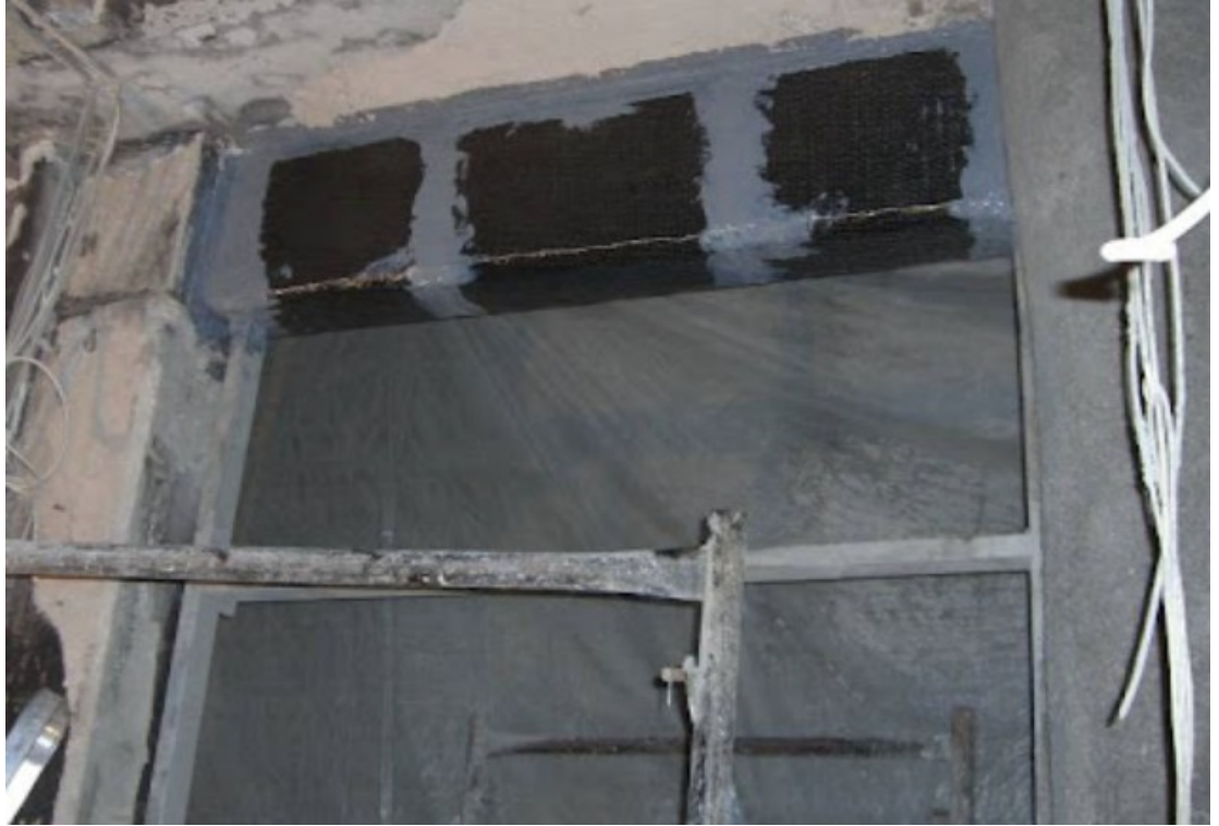
Φωτογραφία 3.2: Εφαρμογή FRP σε δοκό κατοικίας
