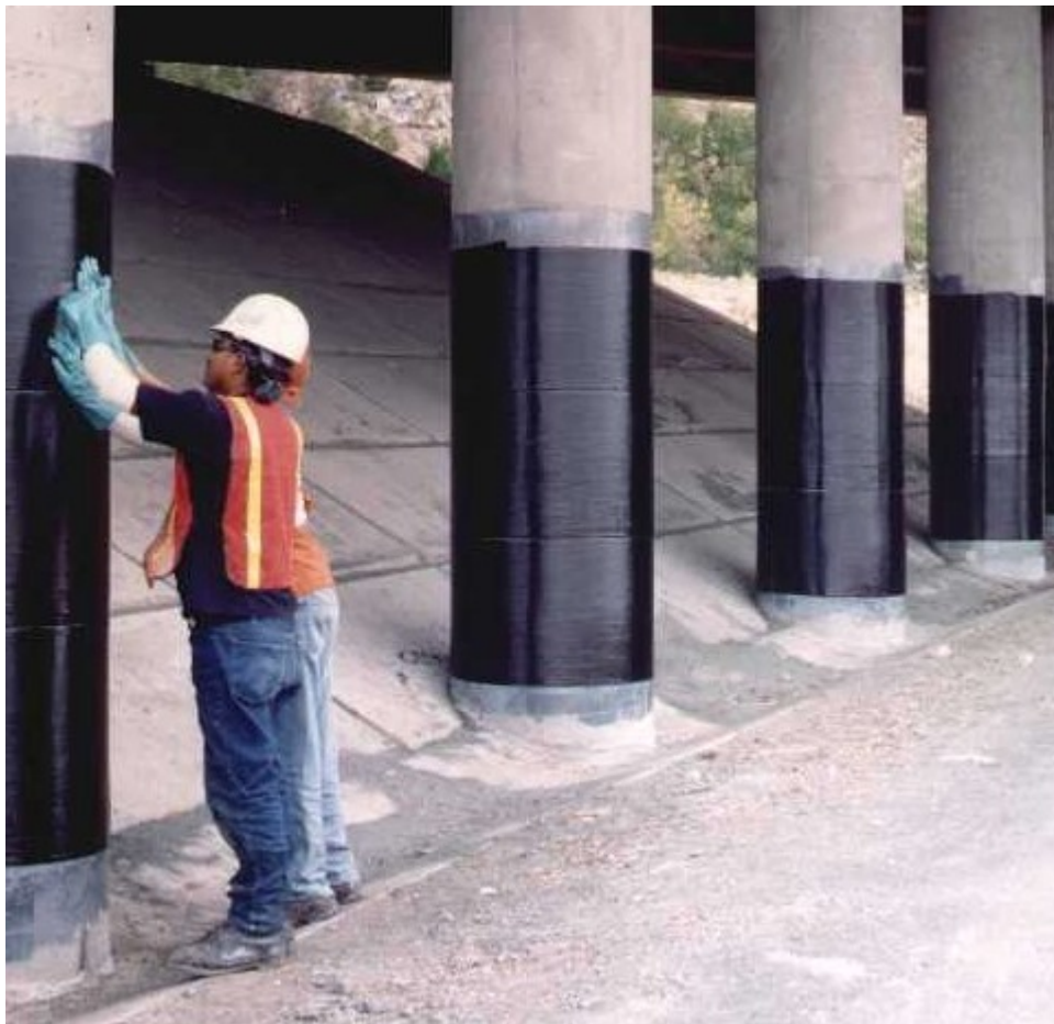
Φωτογραφία 3.1: Εφαρμογή FRP σε υποστυλώματα γέφυρας
