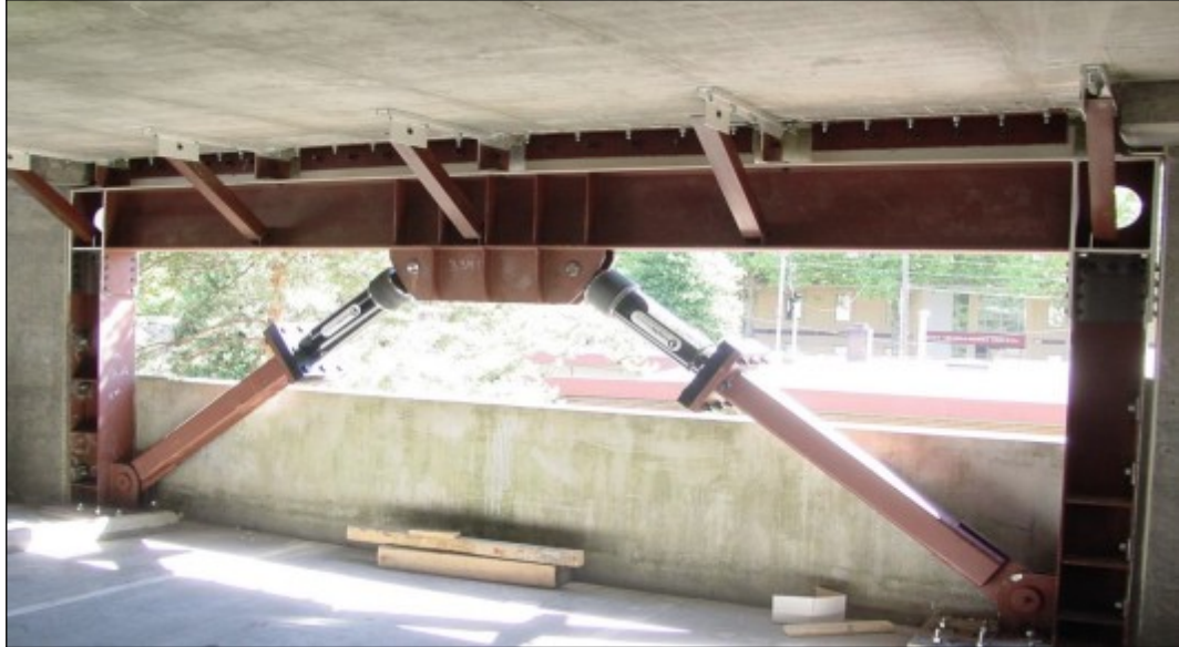
Φωτογραφία 3.5: Εσωτερική σύνδεση σε υφιστάμενο πλαίσιο
