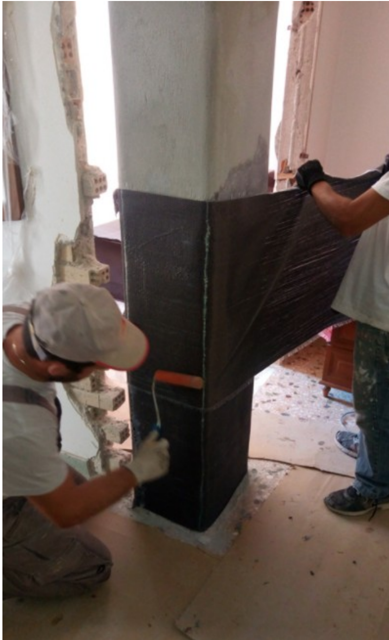
Φωτογραφία 3.3: Εφαρμογή FRP σε υποστήλωμα κατοικίας
