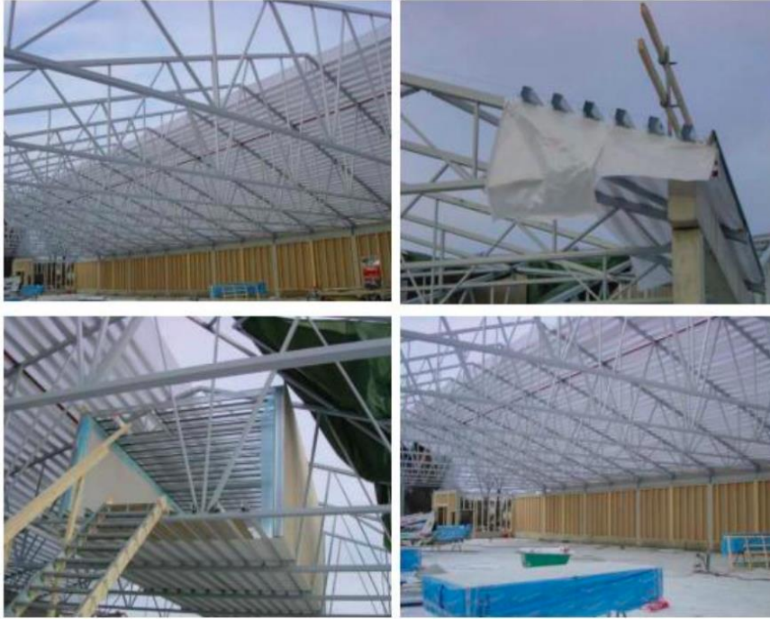
Εικόνα 4.3: Σκελετοί χαλύβδινων πλαισίων χρησιμοποιώντας κοίλες κυκλικές διατομές
