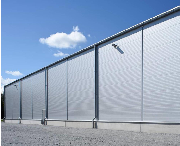
Εικόνα 9.6β: Πλαγιοκάλυψη με πάνελ
