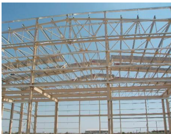
Εικόνα 9.3: Μεταλλικός σκελετός κατοικίας
