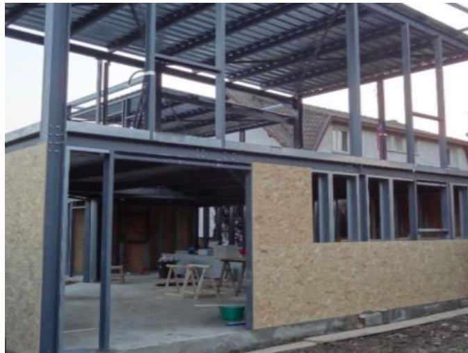
Εικόνα 9.5: Κύριος φορέας μεταλλικού κτιρίου
