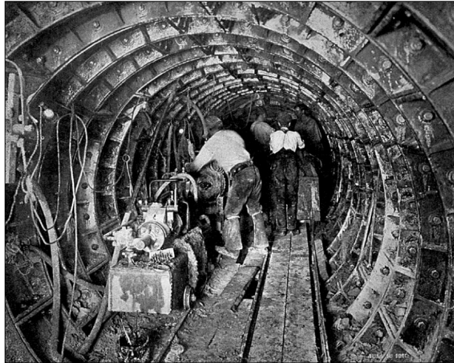
ΕΙΚΟΝΑ 1.3: Διάνοιξη σηράγγων υπονόμων με πεπιεσμένο αέρα, Λονδίνο, 1909 – 1912 (The History of Sanitary Sewers)
