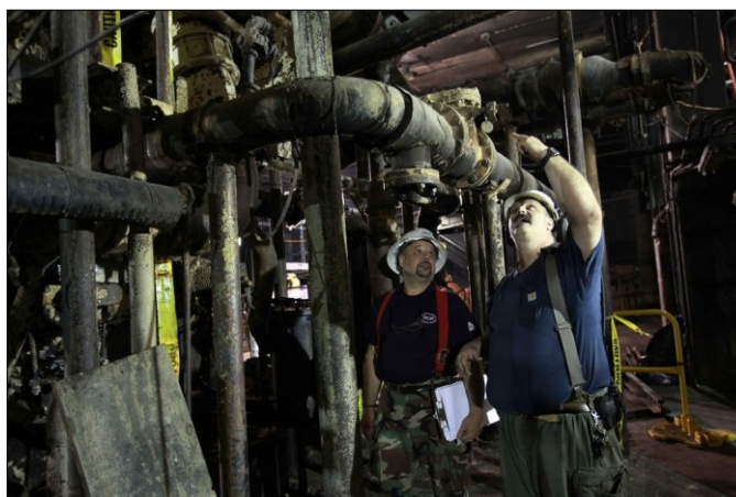
ΕΙΚΟΝΑ 3.4: Έκρηξη στο μηχανοστάσιο Μονάδας επεξεργασίας λυμάτων.
