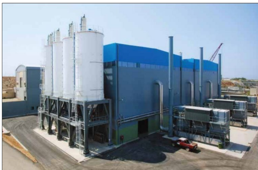
ΕΙΚΟΝΑ 2.3 : Εγκατάσταση Επεξεργασίας Λυμάτων, (ΕΥΔΑΠ, 2011).
