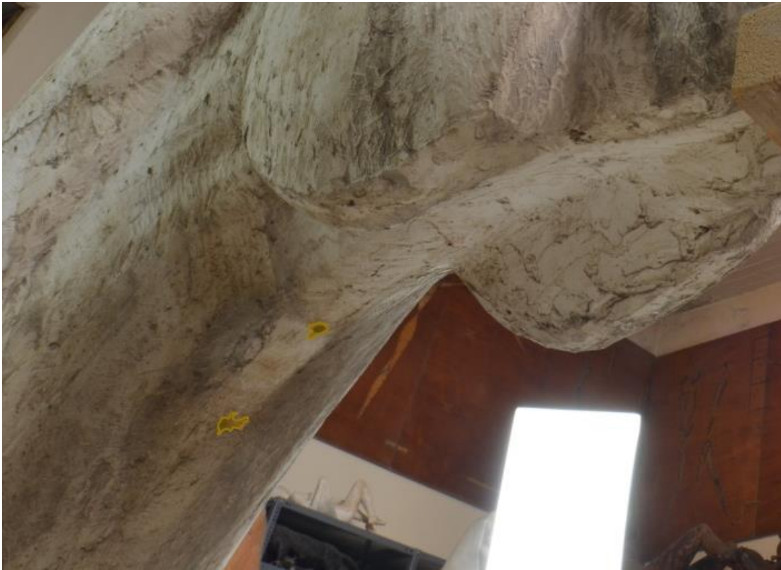
Εικόνα 58: Η χαρτογράφηση των μεταλλικών λεκέδων στο κάτω μέρος του λαιμού του γλυπτού. (Η φωτογραφία είναι από το προσωπικό αρχείο)
