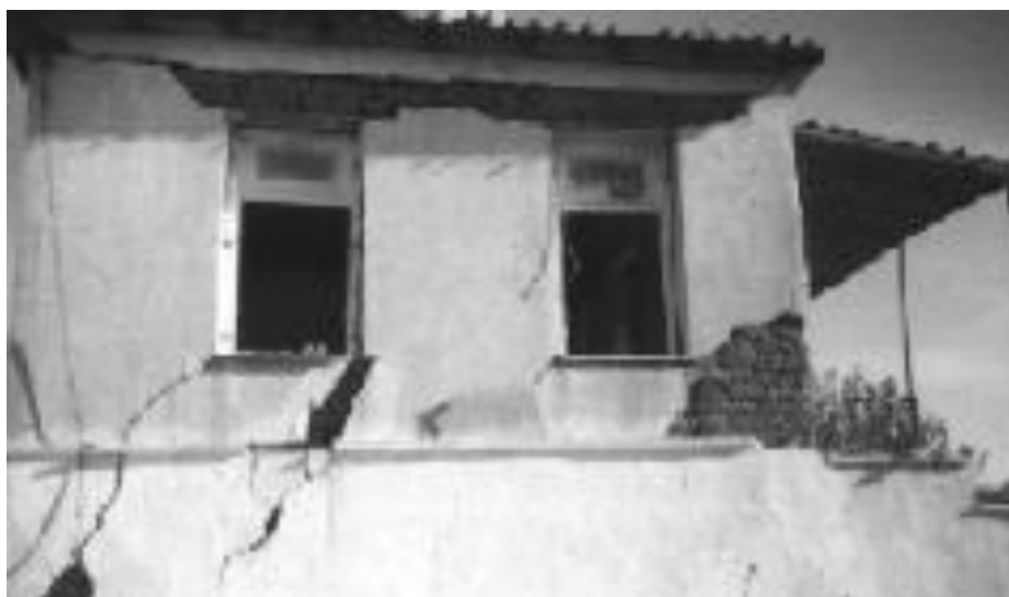
Σχήμα 2. 9: Διατμητική βλάβη τοιχίων (Πηγή: http://teicm.panagop.com/files/ferousa/yliko/Sarigianni/7o_Mathima.pdf )
