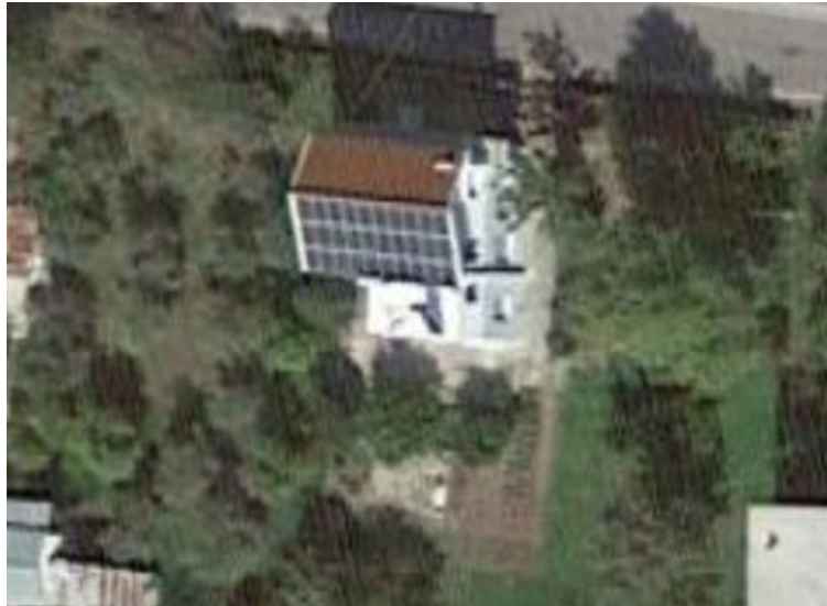
Εικ.15. Χωροθέτηση Φ/Β συστήματος πριν και μετά την ανακατασκευή της στέγης [26]
