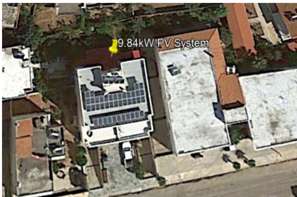
Εικ.5. Φ/Β εγκατάσταση [26]
