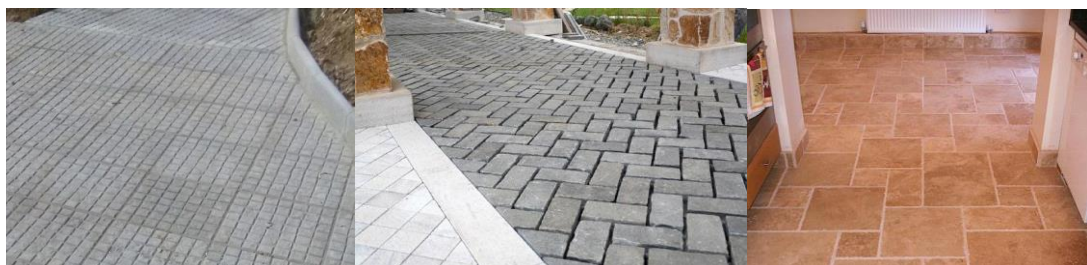
Εικόνα 14: Υλικά Επιστρώσεων α) πλάκες πεζοδρομίου, β) κυβόλιθοι, γ) κεραμικά πλακίδια
