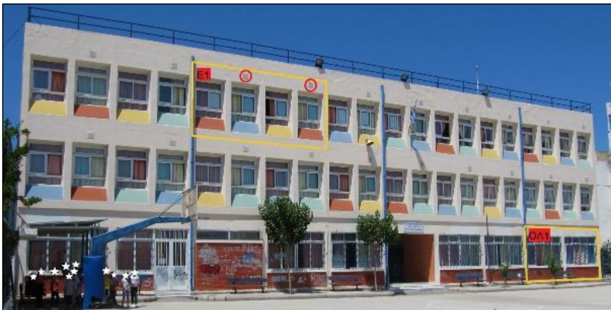
Εικόνα 8: Η θέση της αίθουσας του Ε1 στο δεύτερο όροφο και η θέση της αίθουσας ΟΔ1 στο ισόγειο. Με τους κύκλους σημειώνονται οι θέσεις (έξοδοι αεραγωγών) των ανεμιστήρων τοίχου στο Ε1. Παρακαλούμε να προσεχτεί το διαφορετικό προφίλ των παραθύρων του ισογείου σε σχέση με αυτό των ορόφων, που υπαγορεύεται από τα διαφορετικά χαρακτηριστικά δόμησης (επιπλέον κολόνες στους ορόφους σε σχέση με το ισόγειο). Ανεμιστήρες τοίχου δεν υπάρχουν στο ισόγειο.
