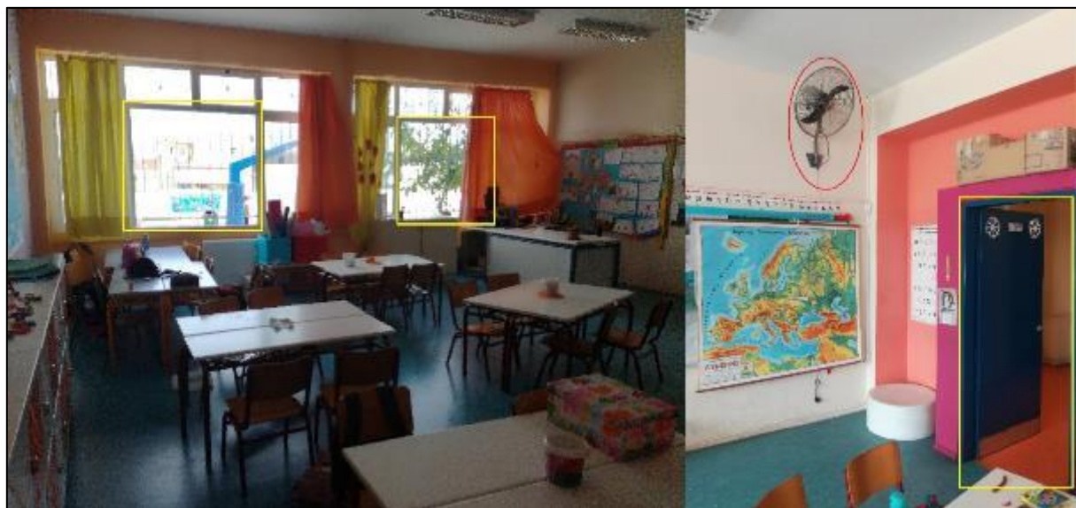
Εικόνα 22: Αριστερά : οι ανοιγόμενες επιφάνειες των παραθύρων (σημειωμένες με κίτρινο). Δεξιά : Η πόρτα της αίθουσας ανοιχτή (με κίτρινο). Ο ανεμιστήρας «ανάδευσης» του υπάρχοντος αέρα (με κόκκινο).
