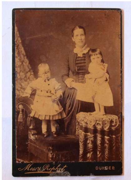
Φωτογραφία 16 – μετά τη συντήρηση
