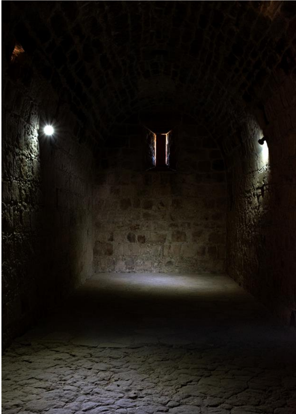
ΕΙΚΟΝΑ 46 ΕΣΩΤΕΡΙΚΟ ΔΩΜΑΤΙΟ ΠΟΥ ΒΡΙΣΚΕΤΑΙ ΣΤΟ ΙΣΟΓΕΙΟ ΤΟΥ ΚΑΣΤΡΟΥ ΚΑΙ ΙΣΩΣ ΤΟ ΧΡΗΣΙΜΟΠΟΙΟΥΣΑΝ ΣΑΝ ΑΠΟΘΗΚΗ. ©ΧΡΥΣΤΑΛΛΑ ΚΟΥΑΛΗ
