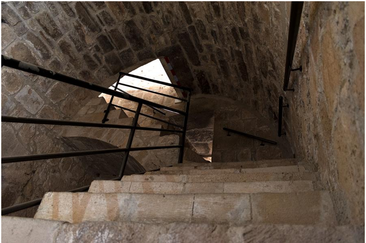
ΕΙΚΟΝΑ 44 ΕΣΩΤΕΡΙΚΕΣ ΣΚΑΛΕΣ ΠΟΥ ΣΥΝΔΕΟΥΝ ΤΟ ΕΙΣΟΓΕΙΟ ΜΕ ΤΟΝ ΠΡΩΤΟ ΟΡΟΦΟ. ©ΧΡΥΣΤΑΛΛΑ ΚΟΥΑΛΗ
