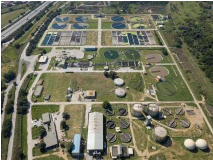
Εικόνα 15: Εγκατάσταση Επεξεργασίας Λυμάτων Θεσσαλονίκης, Πηγή: Ε.Υ.Α.Θ. https://www.evath.gr/apocheteysi/
