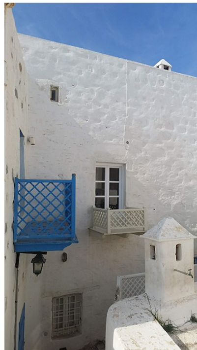
Φωτογραφία 3 - Νότια Όψη
