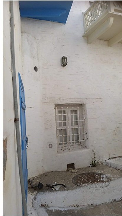
Φωτογραφία 6 - Νότια Όψη
