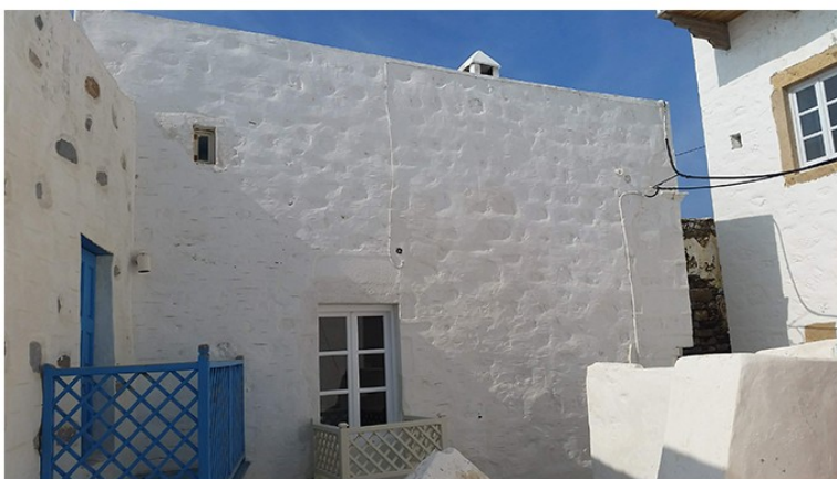
Φωτογραφία 5 - Νότια Όψη
