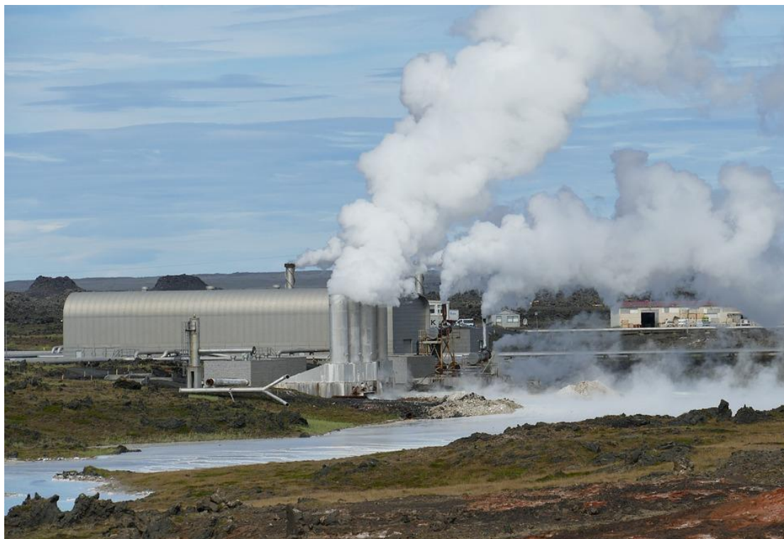
Εικόνα 3.9 Σταθμός Γεωθερμικής Ενέργειας
