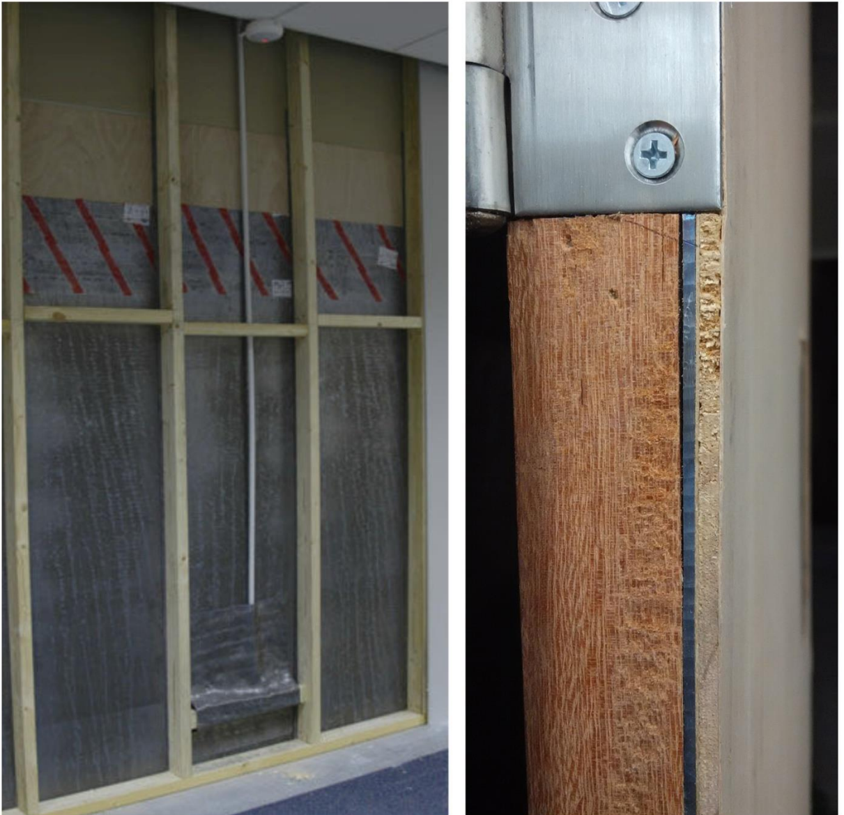
Εικονα 10 Παραδείγματα θωράκισης τοίχων και πόρτας με φύλλα μολύβδου (https://bariumplaster.wordpress.com/2015/07/23/lead-lined-door-glass/ https://www.medicalexpo.com/prod/raybloc/product-70705-445210.html)
