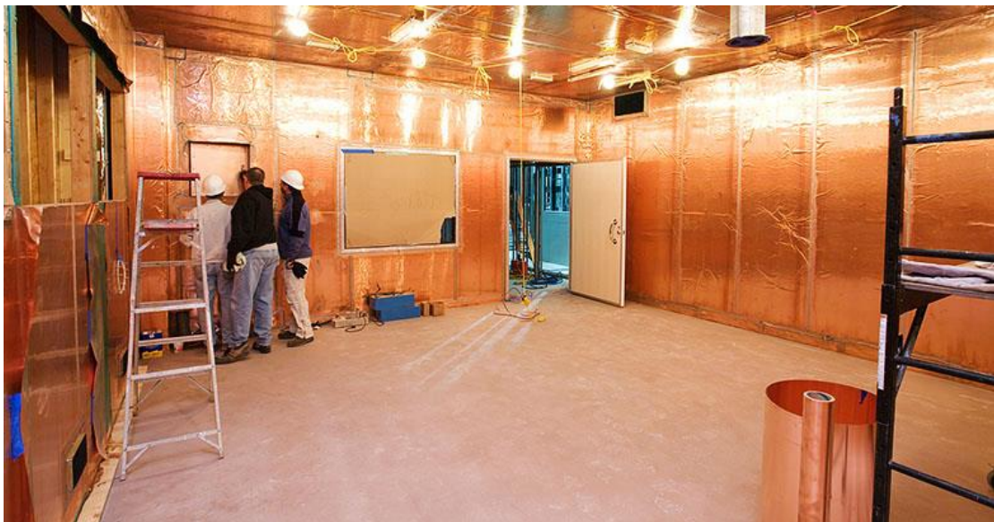
Εικόνα 11 Θωράκιση ραδιοσυχνοτήτων (RF shielding) αίθουσας μαγνητικού τομογράφου με φύλλα χαλκού.
