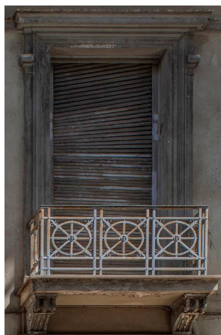
Εικόνα 4.3: Μπαλκόνι με φουρούσια του κτιρίου επί της οδού Θήρας αρ.10
