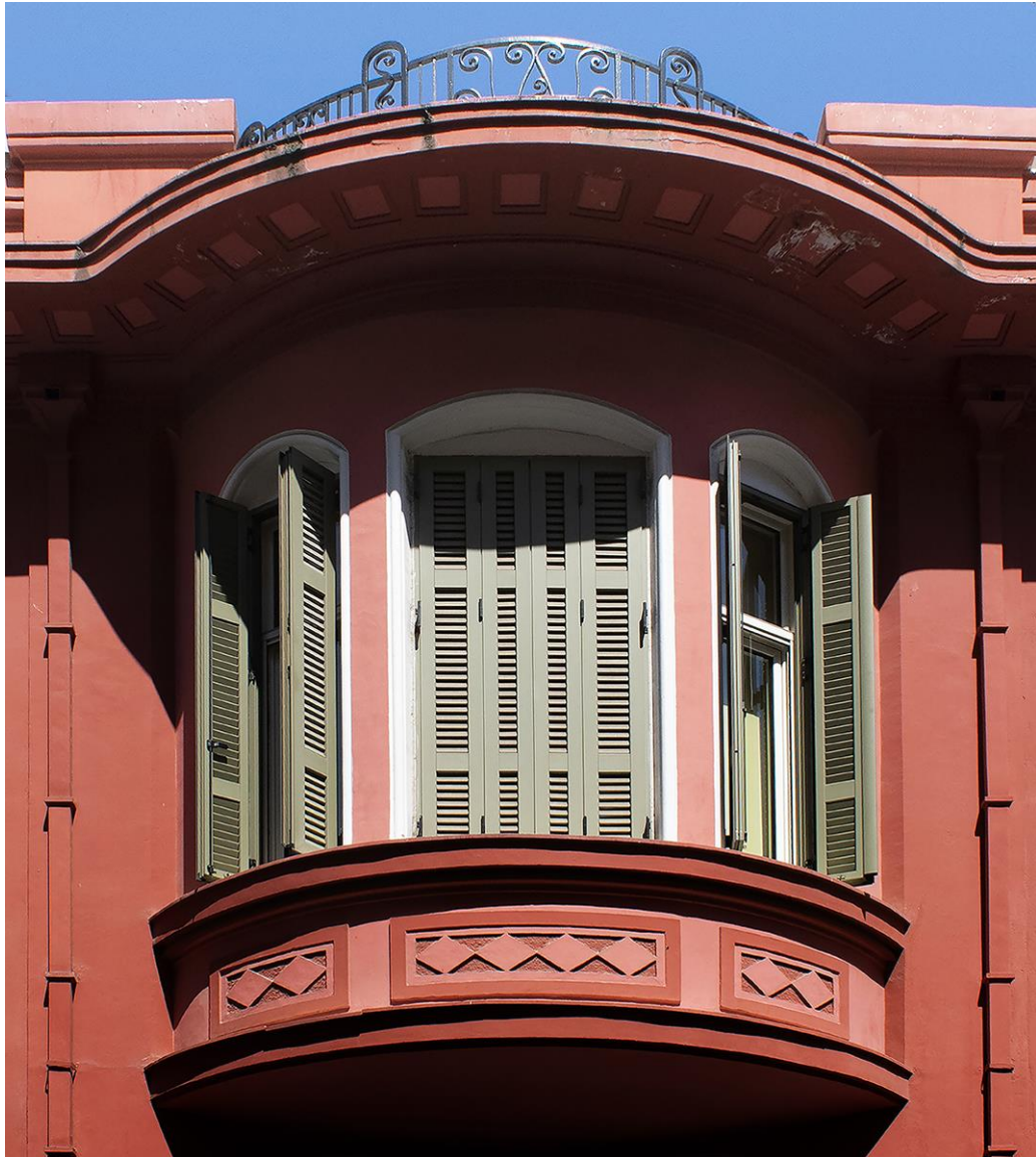
Εικόνα 7.1: Το ημικυκλικό έρκερ του κτιρίου επί της οδού Τήνου αρ.57
