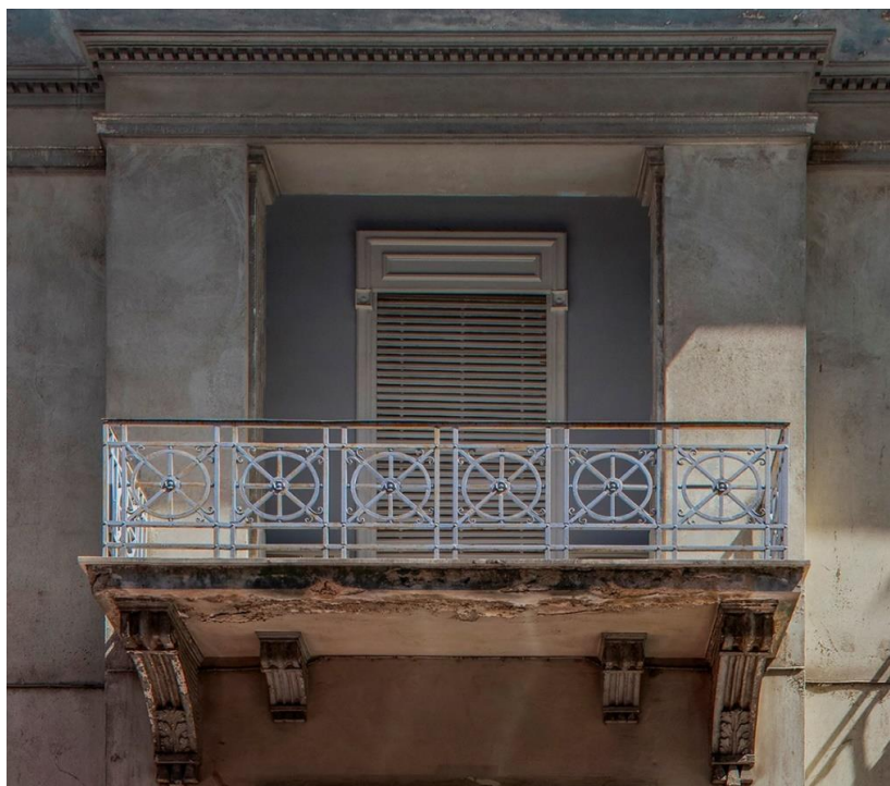
Εικόνα 4.1: Μπαλκόνι με φουρούσια του κτιρίου επί της οδού Θήρας αρ.10
