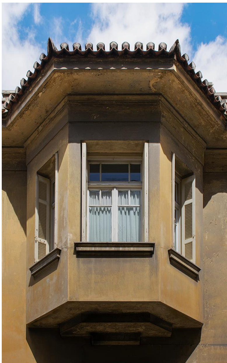
Εικόνα 8.1: Το ημιεξαγωνικό έρκερ και το γείσο της στέγης με τα ακροκέραμα από το κτίριο στη συμβολή των οδών Δροσοπούλου και Πιπίνου
