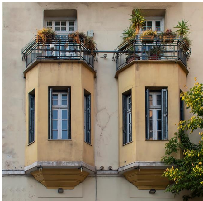
Εικόνα 1.3: Παράθυρα και ημιεξαγωνικά έρκερ- Μέγαρο Μεταξά
