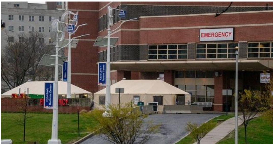
Εικόνα 3.5: Ιατρικό Κέντρο Stamford Jacoby στη Νέα Υόρκη
