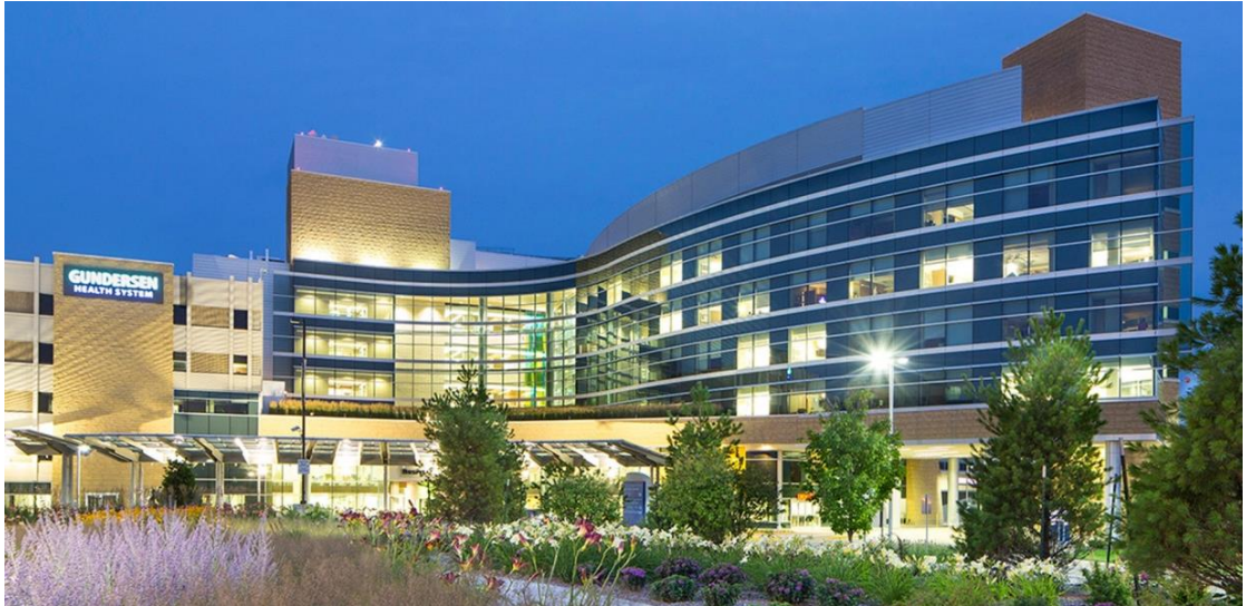
Εικόνα 3.6: Νοσοκομείο Gundersen, La Crosse στο Ουισκόνσιν
