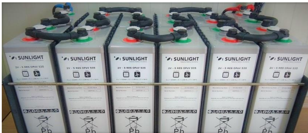
Εικόνα 5.1: Συσσωρευτές, για την αποθήκευση ενέργειας σε κτίρια
