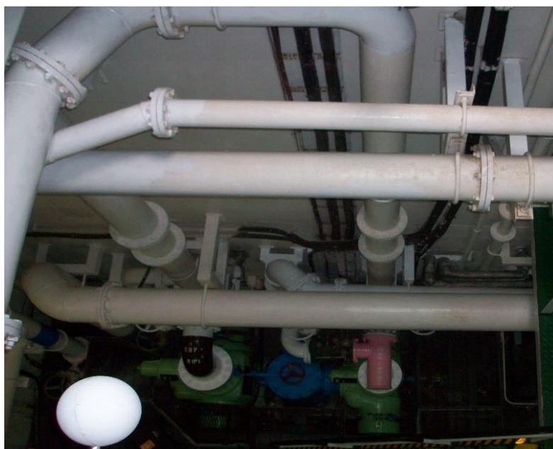
Εικόνα 21: Οι λευκές σφαιρικές ανακλαστικές επιφάνειες επιτρέπουν τη δημιουργία εκτεταμένου νέφους σημείων, που αποτελείται από πολλαπλές διαδοχικές σαρώσεις.
