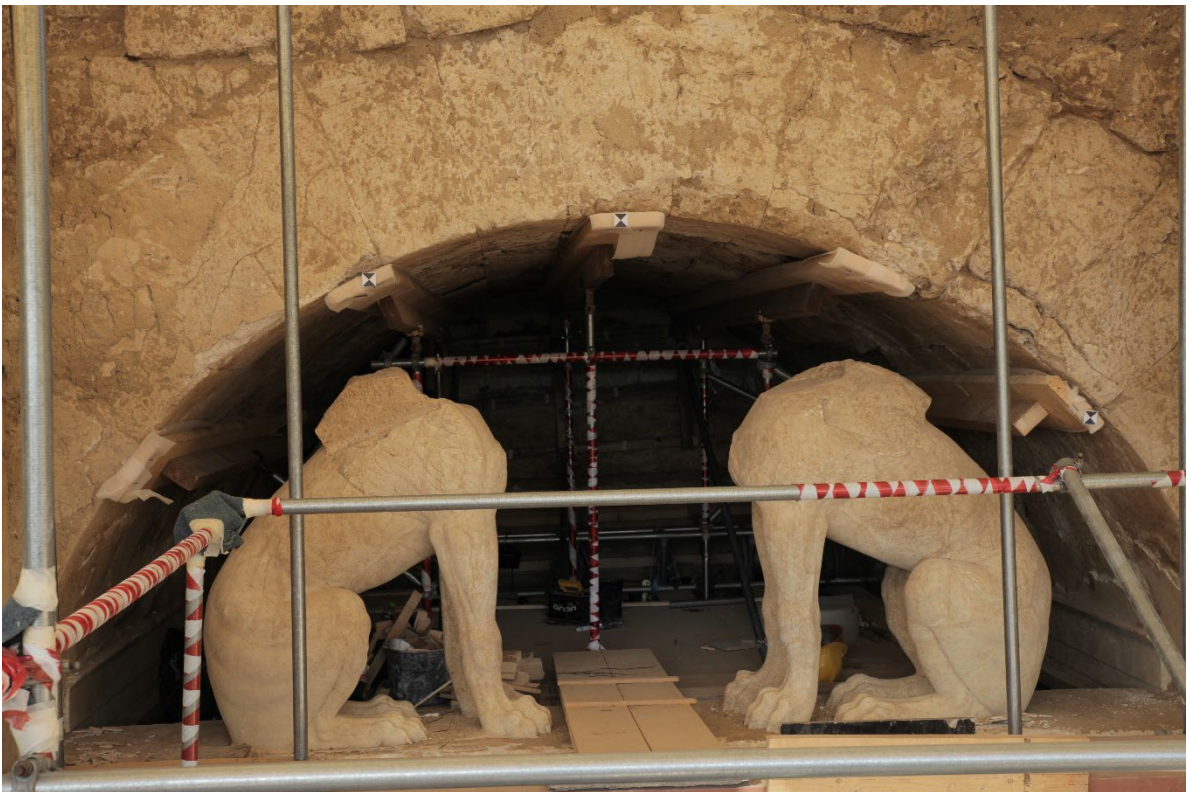
Εικόνα 26. Προσημασμένα φωτοσταθερά περιμετρικά από τις σφίγγες στην είσοδο του τάφου
