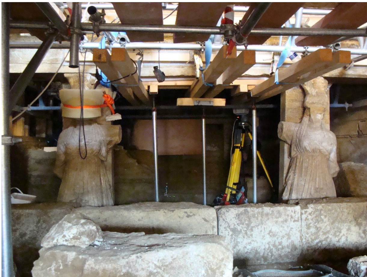
Εικόνα 12. Καρυάτιδες και εργασίες στήριξης οροφής
