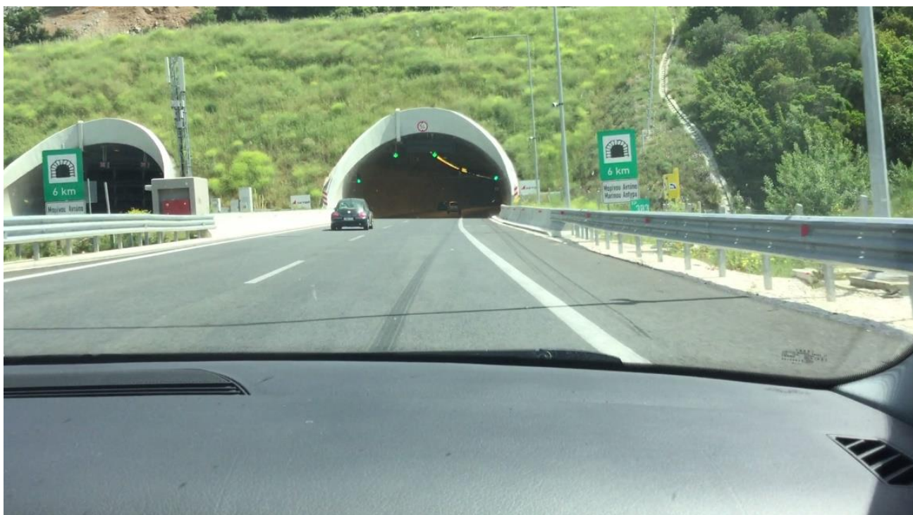
Εικόνα 11: Π.Α.Θ.Ε. Σήραγγα Τεμπών Τ2 (πηγή: el.wikivoyage.org )
