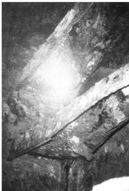
Εικόνα 39: Διαβρωμένα διαμήκη ενισχυτικά. (Πέτρος Α. Καρύδης. Επιθεώρηση, Συντήρηση και Επισκευή της Μεταλλικής Κατασκευής του Πλοίου . Πανεπιστημιακές Εκδόσεις Ε.Μ.Π., 2002.)
