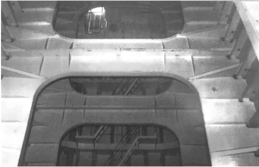
Εικόνα 17: Καλή κατάσταση ( good condition ). (Πέτρος Α. Καρύδης. Επιθεώρηση, Συντήρηση και Επισκευή της Μεταλλικής Κατασκευής του Πλοίου . Πανεπιστημιακές Εκδόσεις Ε.Μ.Π., 2002.)
