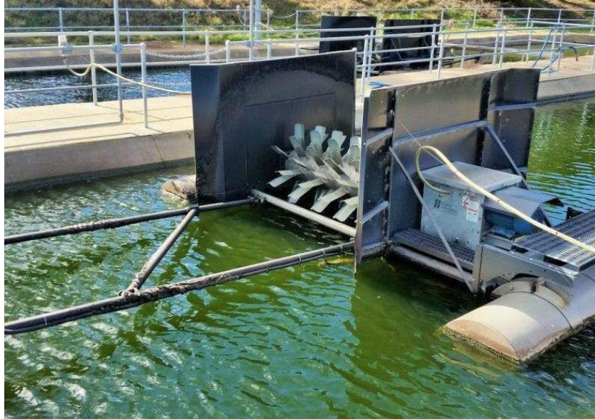
Εικόνα 3.3: Επιφανειακός αεριστήρας με βούρτσα σε λιμνοθάλασσα Πηγή: https://www.makwater.com.au/products/floating-brush-aerators/
