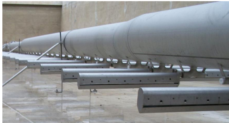
Εικόνα 3.4: Σύστημα αερισμού με χονδροειδείς φυσαλίδες αέρα Πηγή: https://entec-international.com/aeration-coarse-bubble-aeration/#ENTECCoarsebubbleaerationssystem
