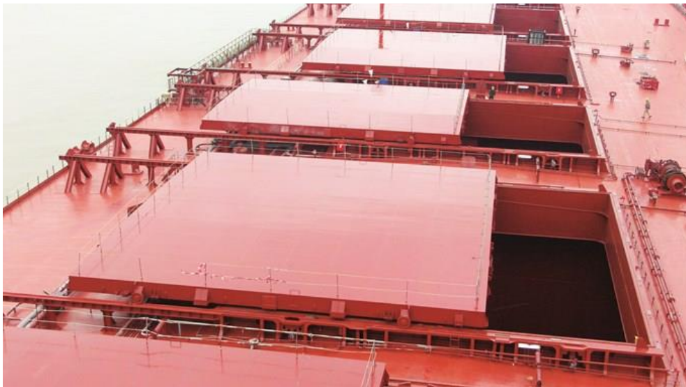
Εικόνα 15. Καλύμματα αμπαριών πλοίου σε ανοιχτή θέση για έλεγχο (πηγή: https://safety4sea.com/lessons-learned-cargo-damage-caused-by-leaking-hatch-covers/ ).
