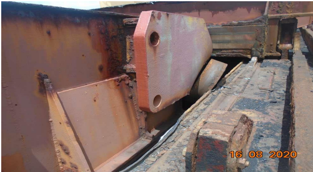
Εικόνα 17. Σημάδια διάβρωσης στους τροχούς και τις ράγες οδήγησης (πηγή: Alatas Singapore Pte Ltd. 2020).
