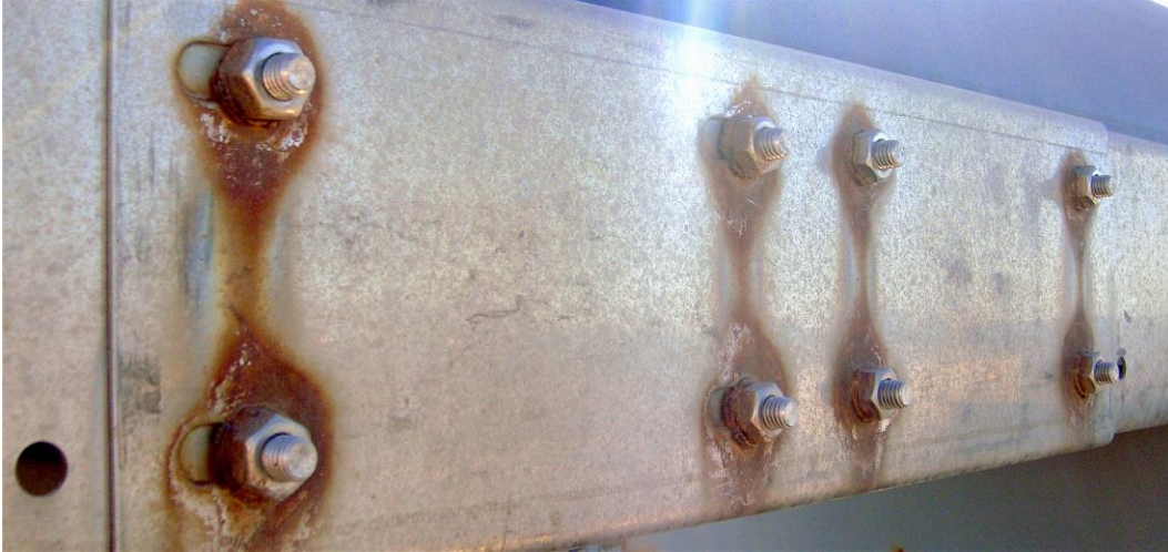
Εικόνα 4. Γαλβανική διάβρωση σε διαφορετικά μέταλλα που βρίσκονται σε επαφή, (πηγή: https://www.wikiwand.com/en/Galvanic corrosion ).
