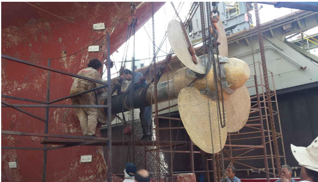
Εικόνα 21. Αποσυναρμολόγηση του άξονα της έλικας (πηγή: https://mpss.gr/el/projects/controllable-pitch-propeller-o-rings-replacement/ ).
