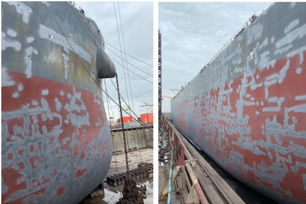
Εικόνα 32. Τοπική βαφή στα σημεία με εντονότερη διάβρωση (πηγή: Chartworld Shipping Corp. 2020).
