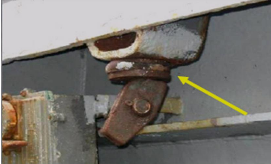
Εικόνα 9. Κοτσαδόρος με σημάδια ομοιόμορφης διάβρωσης, όπως εντοπίστηκαν κατά την επιθεώρηση (Μαγιορ 2013α).
