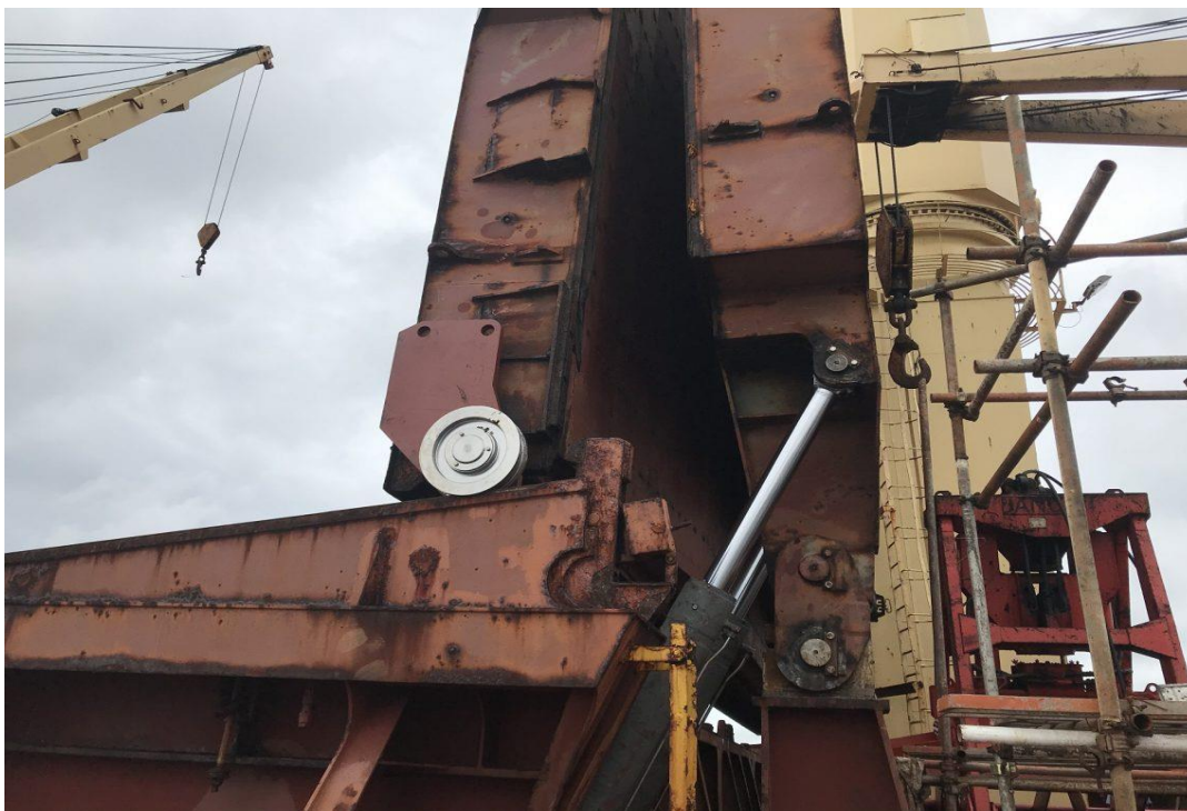
Εικόνα 18. Αντικατάσταση τροχού οδήγησης και κυλίνδρου ανύψωσης (πηγή: Alatas Singapore Pte Ltd. 2020).
