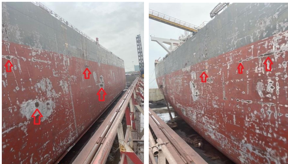
Εικόνα 30. Μέρος της γάστρας του πλοίου έπειτα από καθαρισμό βαθμού Sa2 με αμμοβολή (πηγή: Chartworld Shipping Corp. 2020).
