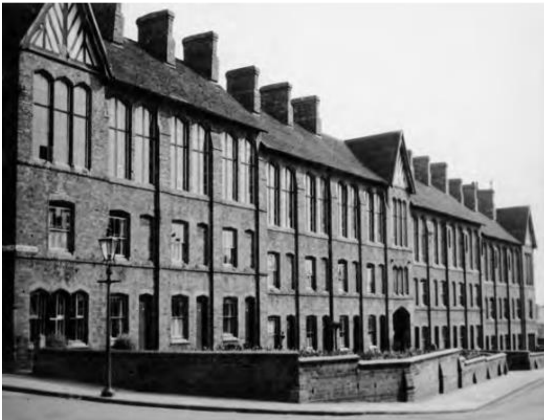
Εικόνα 1.3 Αγροικία - εργοστάσιο του δέκατου 19 ου αιώνα στο Κόβεντρι της Αγγλίας για την παραγωγή κορδέλας (Holliss, 2019)
