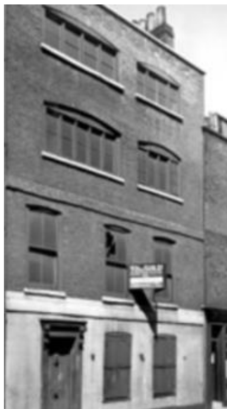
Εικόνα 2.6 Workhome κατοικία οικογενειακής επιχείρησης ύφανσης μεταξιού (Holliss, 2015)
