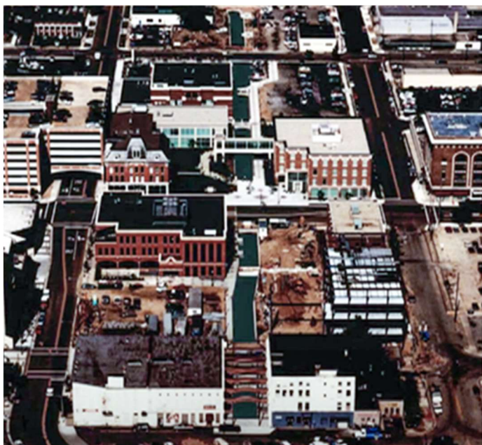
Εικόνα 8 Πριν την αποκατάσταση του ρέματος
