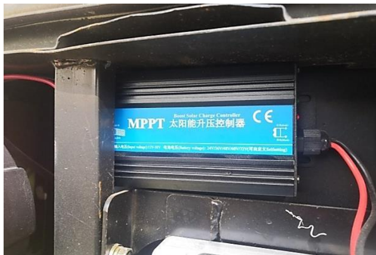
Εικόνα 2.4 Ρυθμιστής φόρτισης φωτοβολταϊκού πλαισίου
