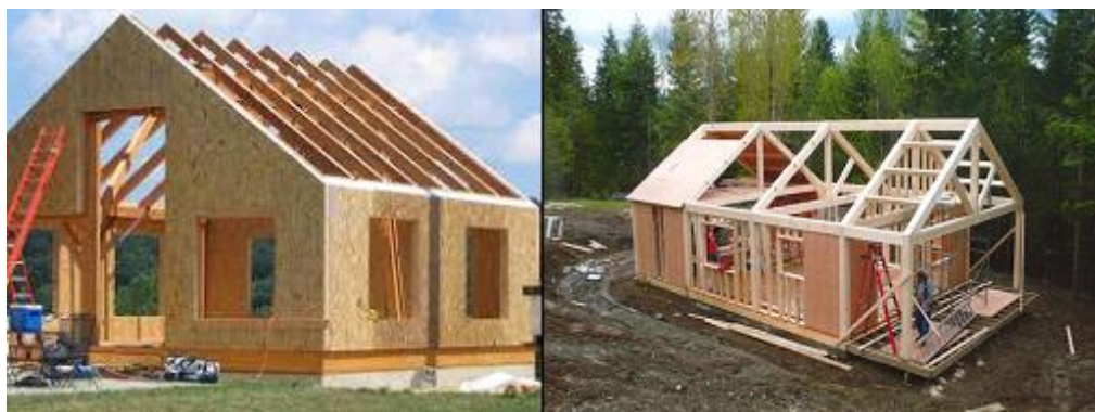
(Εικ. 7) κατασκευές με ξύλινο σκελετό
