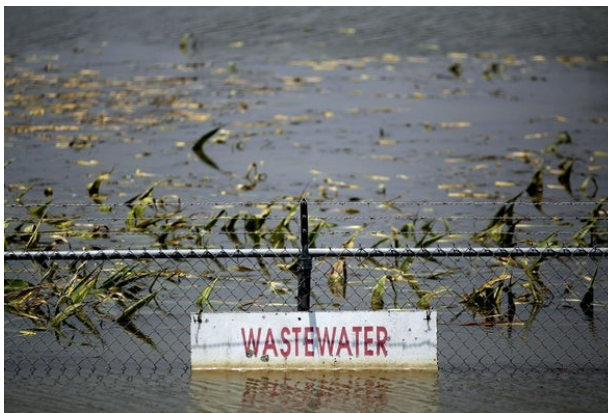
Εικόνα 3.15: Πλημμύρα σε μονάδα επεξεργασίας λυμάτων (KavyaBalaraman, 2016).
