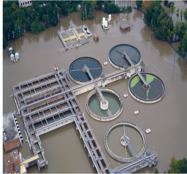
Εικόνα 3.18: Ολική καταστροφή εγκατάστασης (πλημμύρα) μετά από τυφώνα Χάρβεη στο Τέξας (HunterPowell, 2018)
