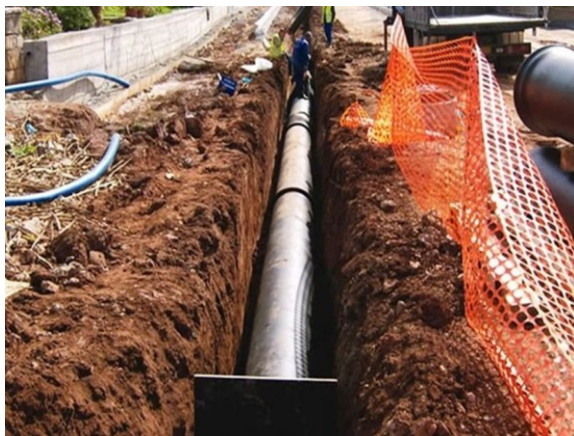
Εικόνα 1.3: Υπόγειο δίκτυο μεταφοράς λυμάτων στη Σύρο (Cyclades24, 2020).
