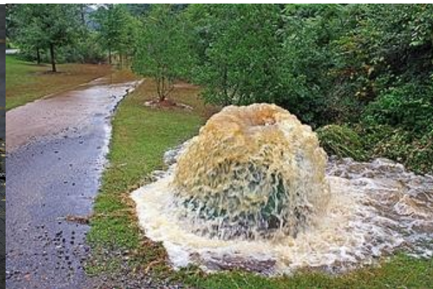
Εικόνα 3.16: Υπερχείλιση αποχετευτικού αγωγού (AlanCressler, USGS, 2009).
