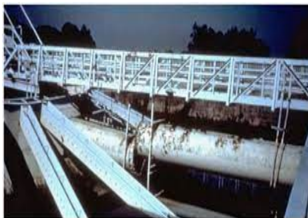
Εικόνα 3.20: Κατεστραμμένος διανυστήρας μετά από δυνατό σεισμό (EPA, 2015).
