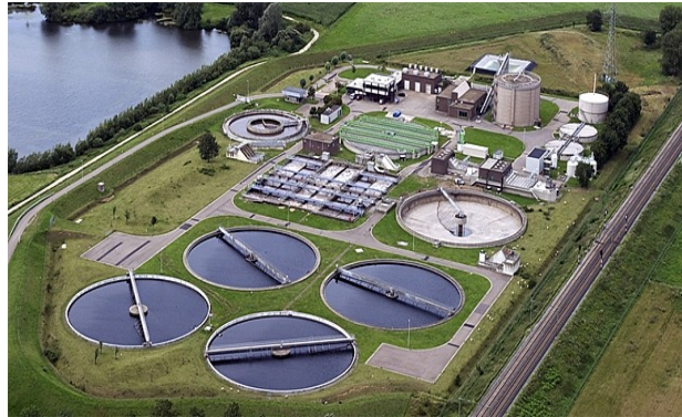
Εικόνα 1.2: Εγκατάσταση Επεξεργασίας Λυμάτων ( SalmanZafar, 2022).
