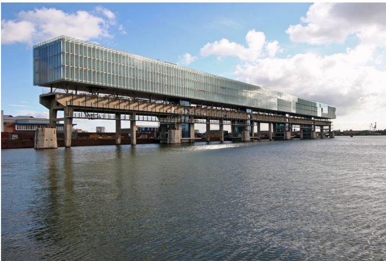
Εικόνα 21. Kraanspoor πριν και μετά την προσθήκη της νέας κατασκευής
