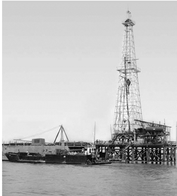
Σχήμα 1-3 Η πλωτή μονάδα παραγωγής της εταιρείας Kerr-Mc Gee Oil ( https://www.geoexpro.com/articles/2008/04/pioneering-production-from-the-deep-sea ).
